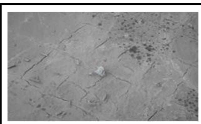
**Figure 1.69.** Les fissures en surface de retrait.
