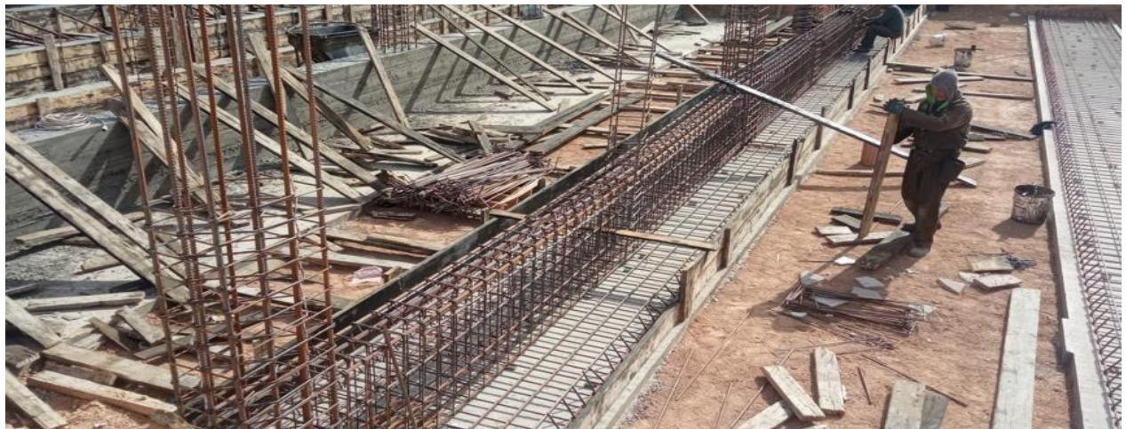
Figure.1.48. Ferraillage de la poutre libage et Ferraillage de la semelle
