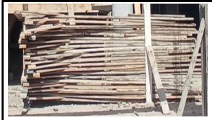
**Figure.1.28.** Stockage des panneaux de coffrage.
