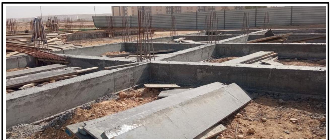
**Figure.1.52.** Le béton de l'infrastructure.
