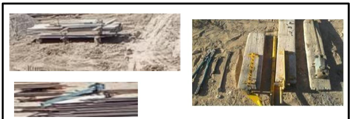
**Figure 1.16.** Le matériel de ferraillage.
