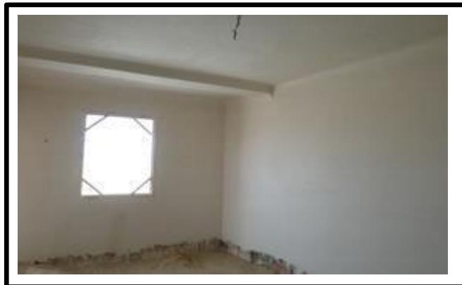
**Figure.1.74.** Enduit au plâtre.
