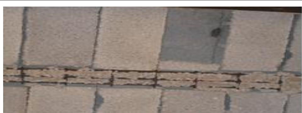
**Figure.1.66.** La ségrégation de béton au niveau des poutrelles.
