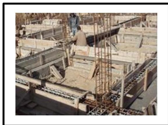
**Figure.1.49.** Coulage de la poutre libage.
