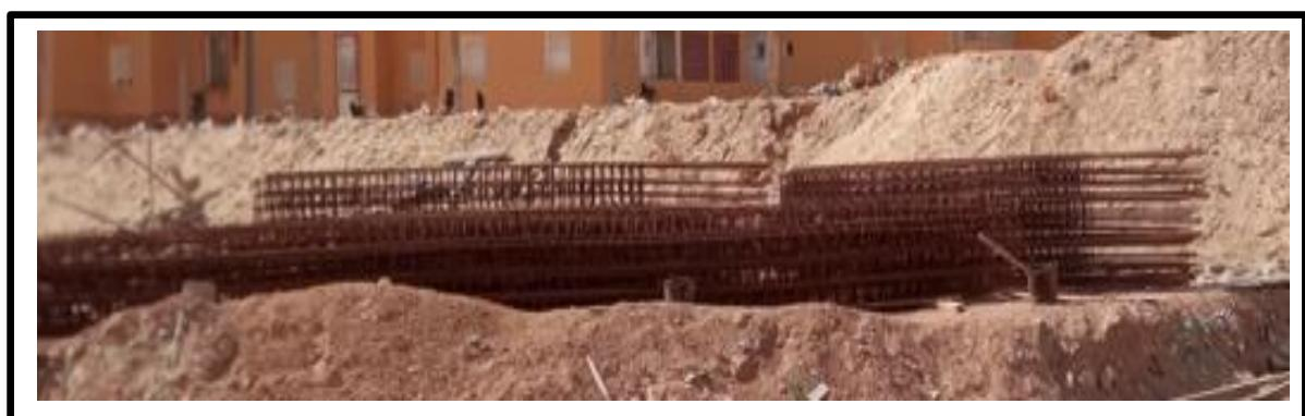
**Figure.1.13.** Stockage des ferraillages.
