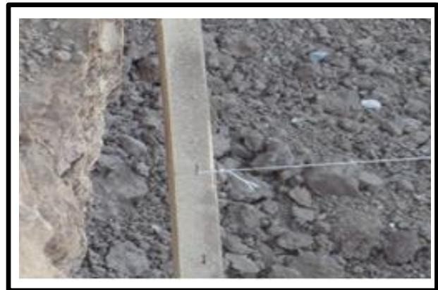
**Figure 1.44.** les axe de la structure.
