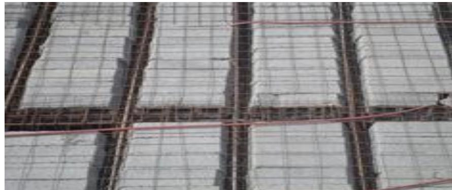
**Figure.65** le corps creux et pose du treillis soudé
