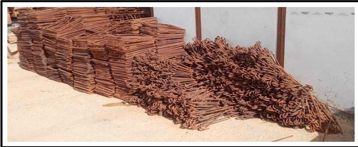
**Figure.1.14.** Stockage des cadres et épingle.
