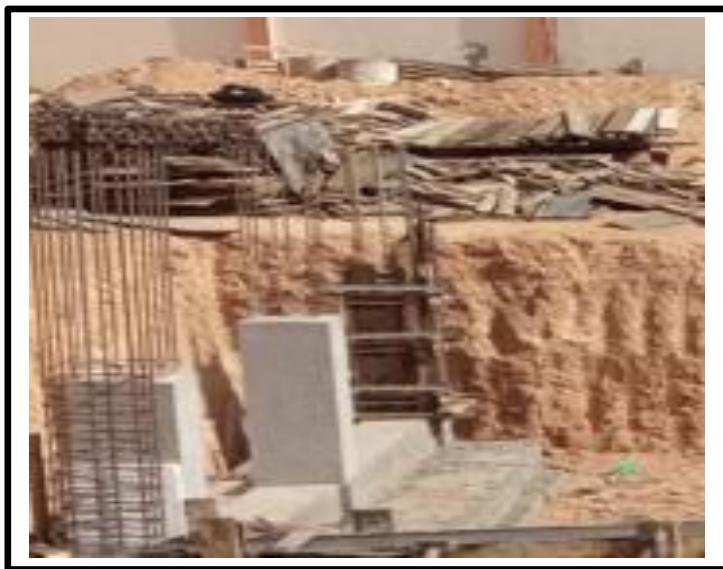
**Figure.1.51.** Ferraillage et coulage de l'amorce poteau.
