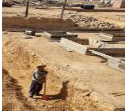
Figure.1.46 Coffrage du béton propreté.
