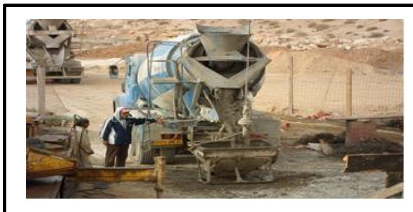
**Figure.1.19.** Contrôle de la qualité du béton avant le coulage.
