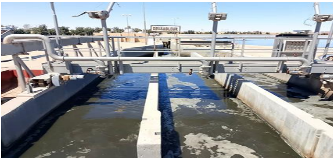
Figure I.6 : Répartiteur vers les bassins d'aération
