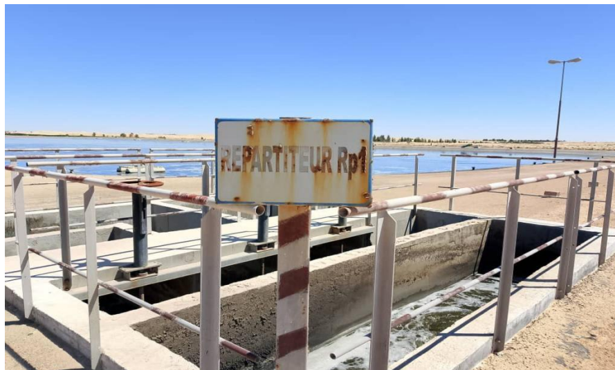
Figure I.9 : Répartiteur vers les bassins d'aération
