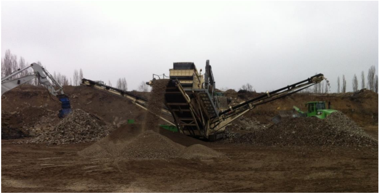
Figure 1. 3: Concassage des déchets de démolition (Centrale de tri Picheta dans le val d'Oise) [20]
