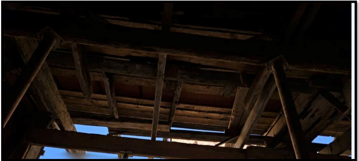
Figure.36 : Coffrage des balcons.
