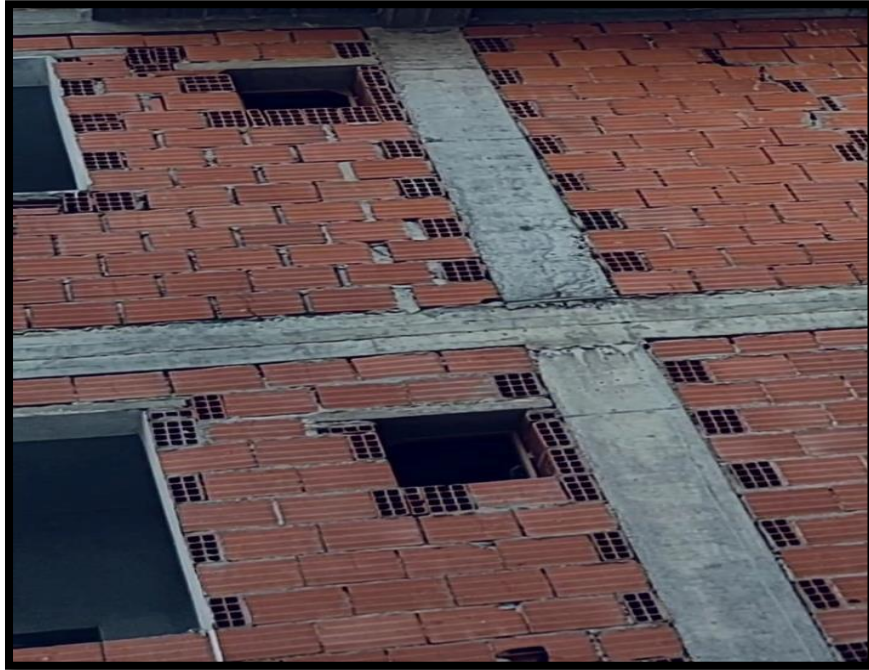
Figure.41 : Défaut de l'élément court.
