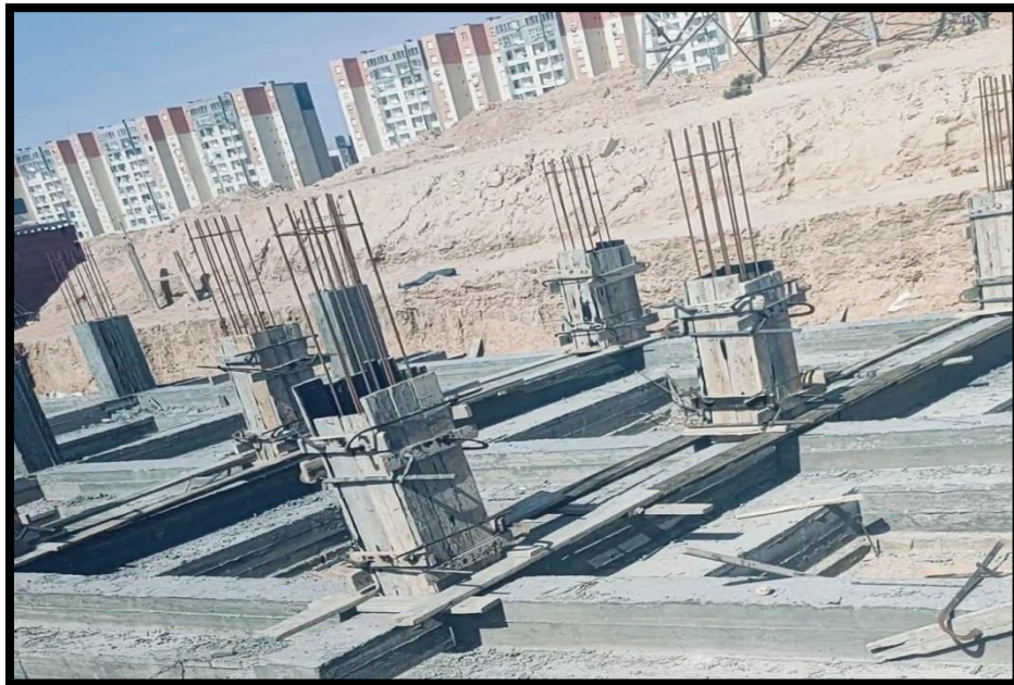
Figure.26 : Semelle filant après coulage.
