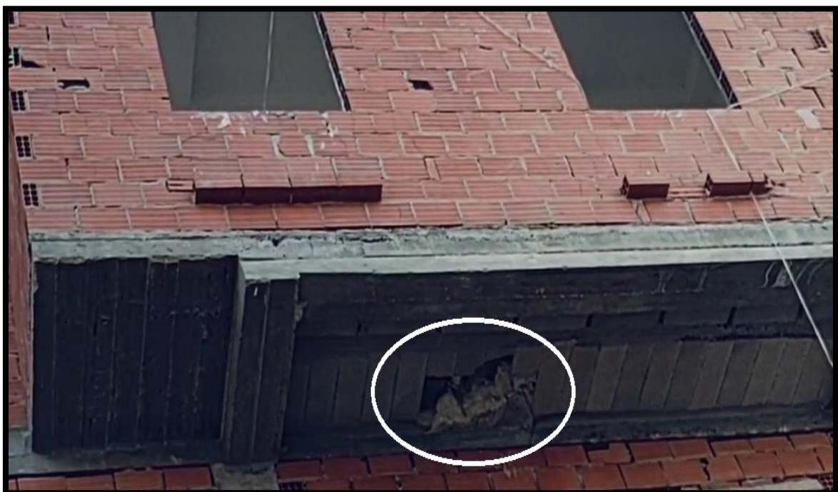
Figure 40 : Présence de réfraction au niveau de corps creux.
