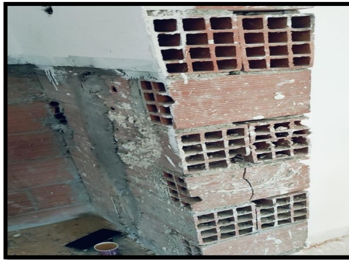
Figure.43 : Mur intérieurs 10 cm d'épaisseur.
