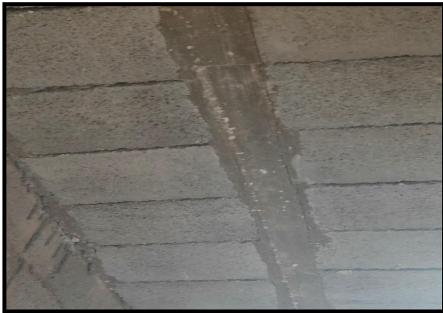
Figure .35 : Décoffrage des planchers.
