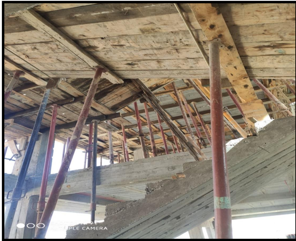
Figure.32 : Coffrage de l'escalier.
