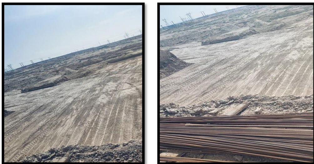
Figure.22 : Décapage des terrains.
