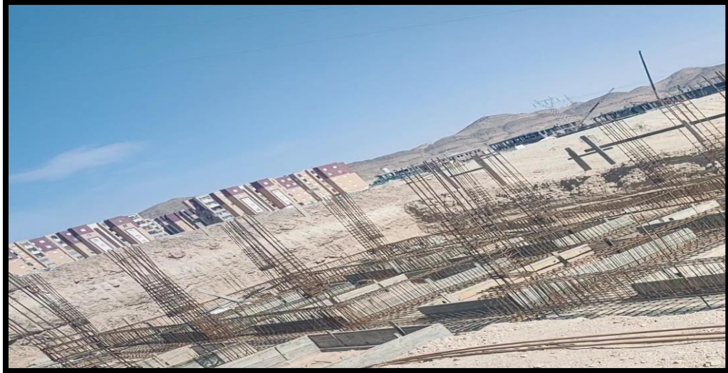
Figure.25 ferrailage des semelles filant.
