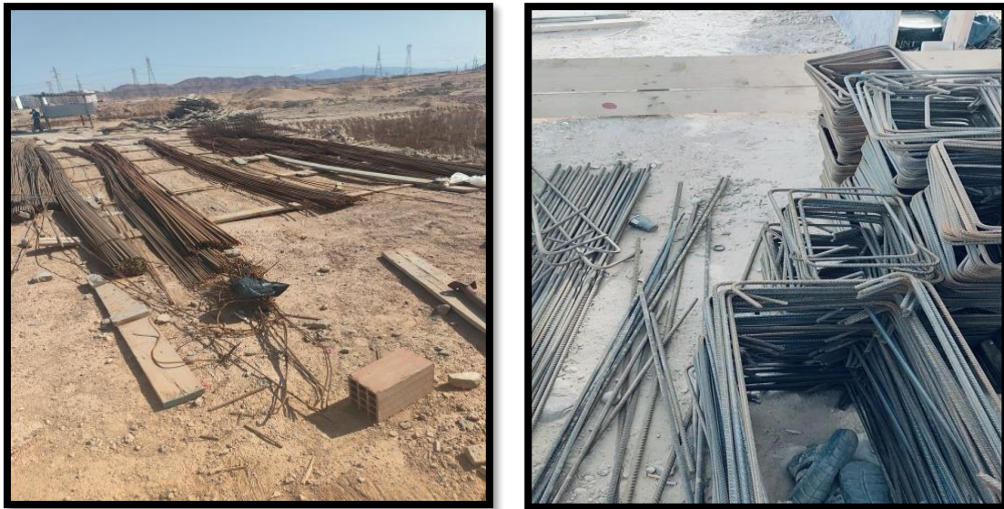
Figure.9: aire de stockage du ferrailage
