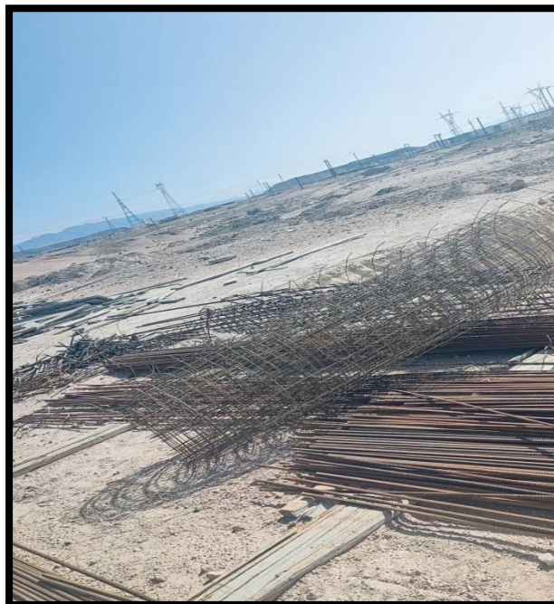
Figure .14 :L'acier stocké directement sur le terrain.
