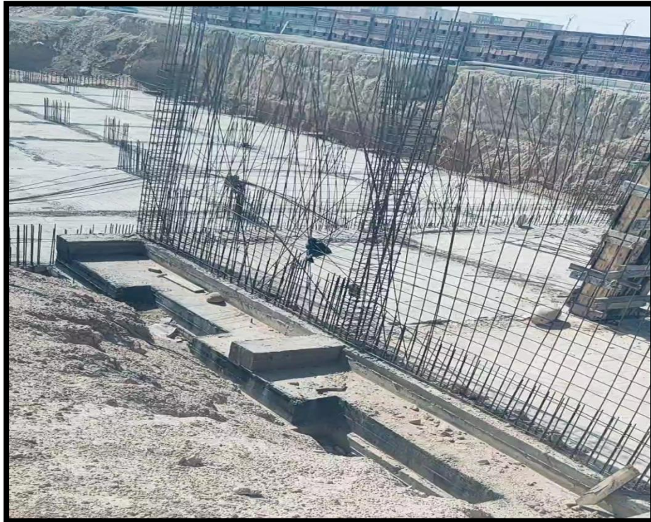
Figure .29 : Ferrailage de voile.
