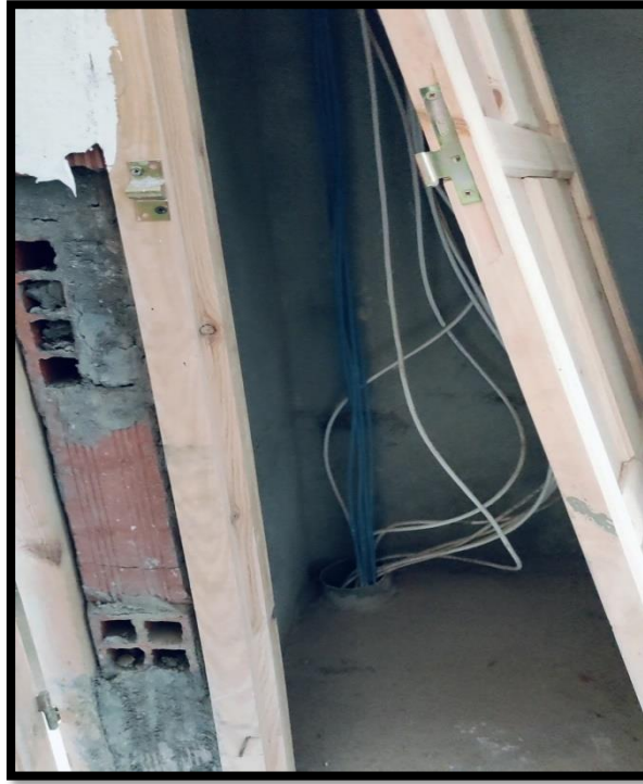
Figure.44 : Passage des gaines et du câble d'électricité.
