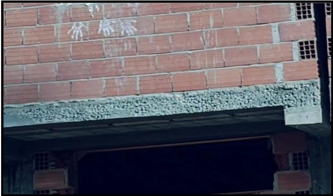
Figure.39 : Défaut de manque de vibration.
