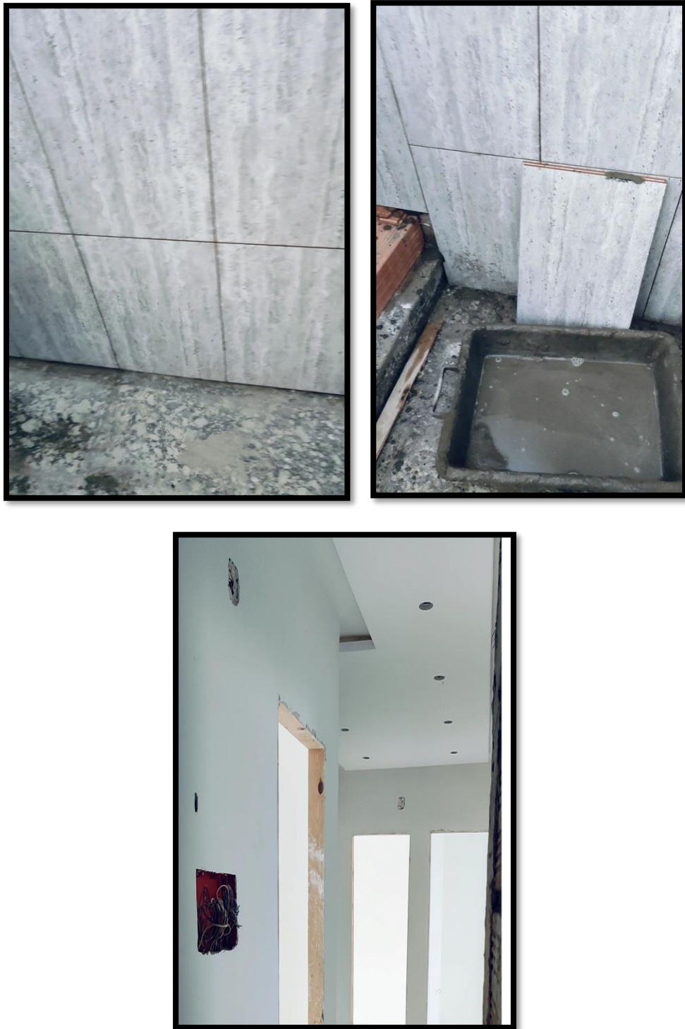
Figure. 46 : Revêtement des murs et des plafonds
