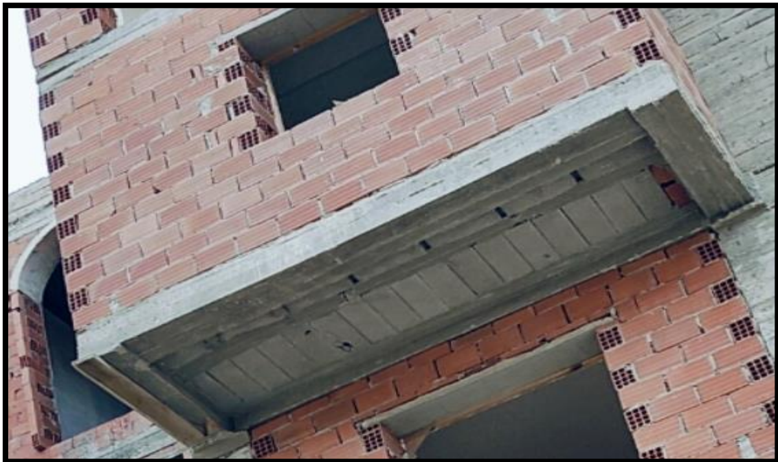
Figure .42 : Défaut de ferrailage de balcon (corps creux)
