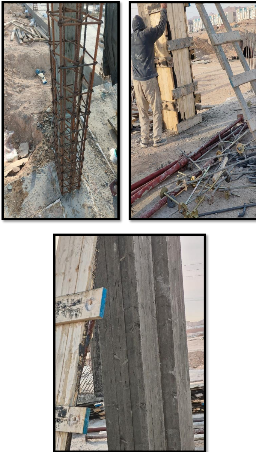
Figure.31: Ferrailage, coffrage et décoffrage des poteaux.
