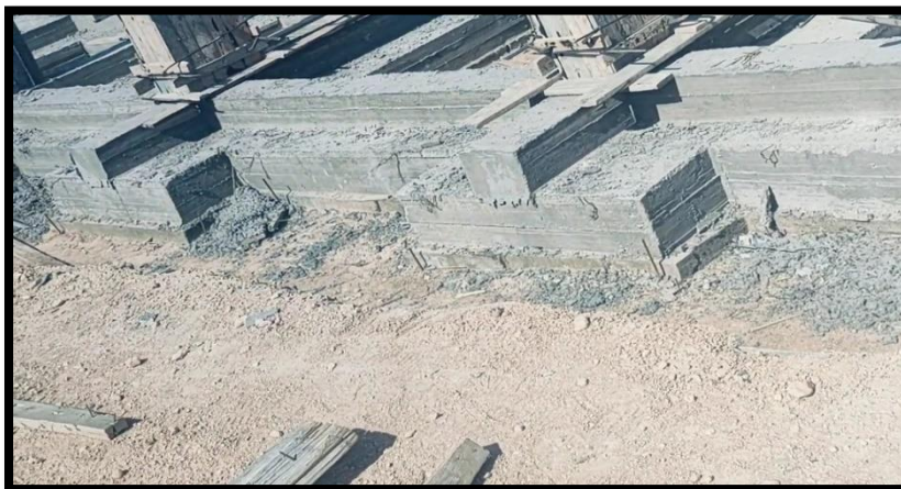
Figure.24 : Le béton cyclopéen après coulage.
