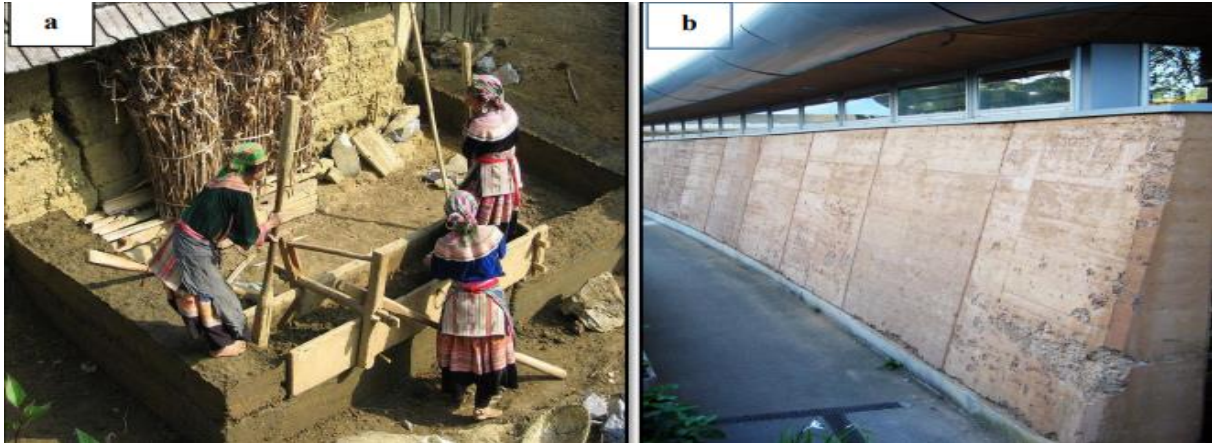
Figure 1. 3a) Méthode de fabrication d'un mur en pisé pour une maison Hmong au Vietnam ; b) L'entrée de l'édifice du Projet Eden en Cornouailles, en Angleterre, au Royaume-Uni [4]
