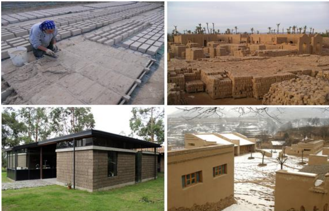
Figure 1. 7 Fabrication de briques d'adobe à petite échelle industrielle à Palencia, Espagne. b) Stockage massif de briques d'adobe, Villa Janna, Marrakech, Maroc. c) Maison contemporaine en adobe non enduite, Lienzo de Barro, Équateur. d) École maternelle contemporaine fabrication de briques d'adobe à petite échelle industrielle à Palencia, Espagne. [1]
