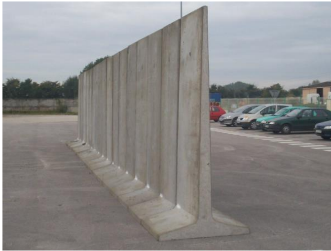
Figure 1- 6: Mur en T renversé classique
