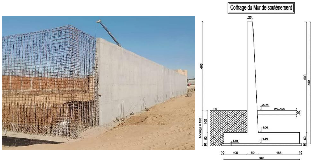
Figure 1- 1: Mur de soutènement
