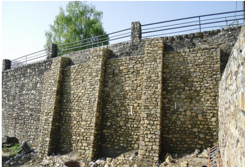
Figure 1- 8: Mur à contreforts
