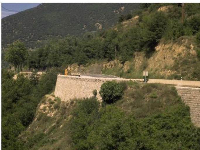
Figure 1- 4: Mur en poids
