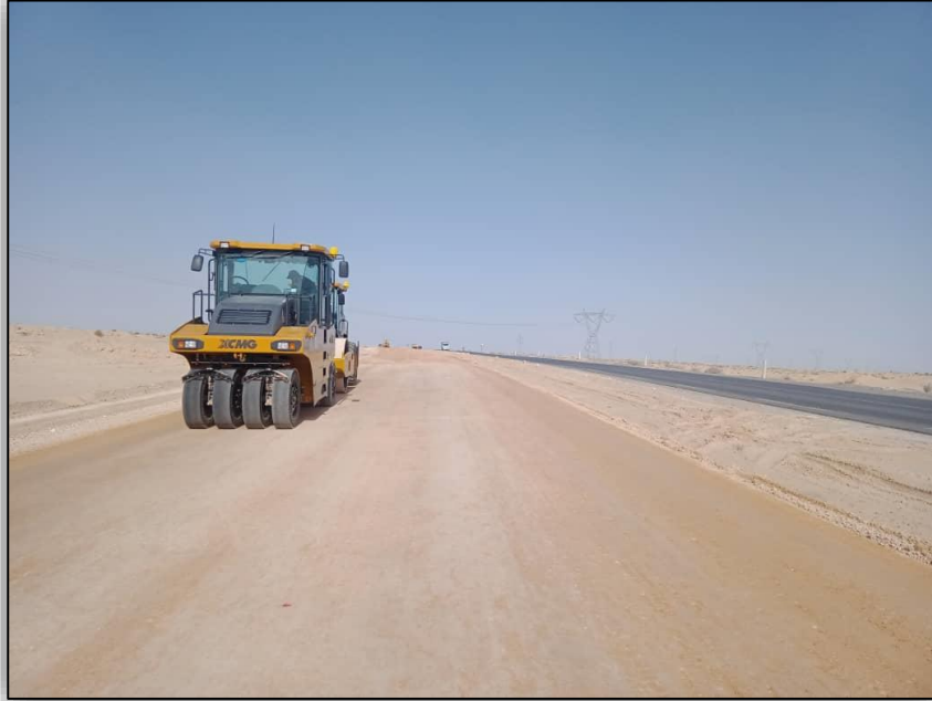
Photo II-09 : Compactage couche de fondation « GNT 0/31,5 »
