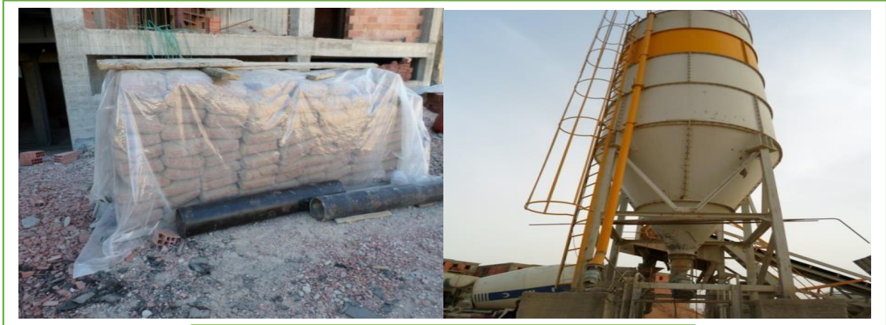
Le Ciment : le stockage de ciment dans le chantier.
