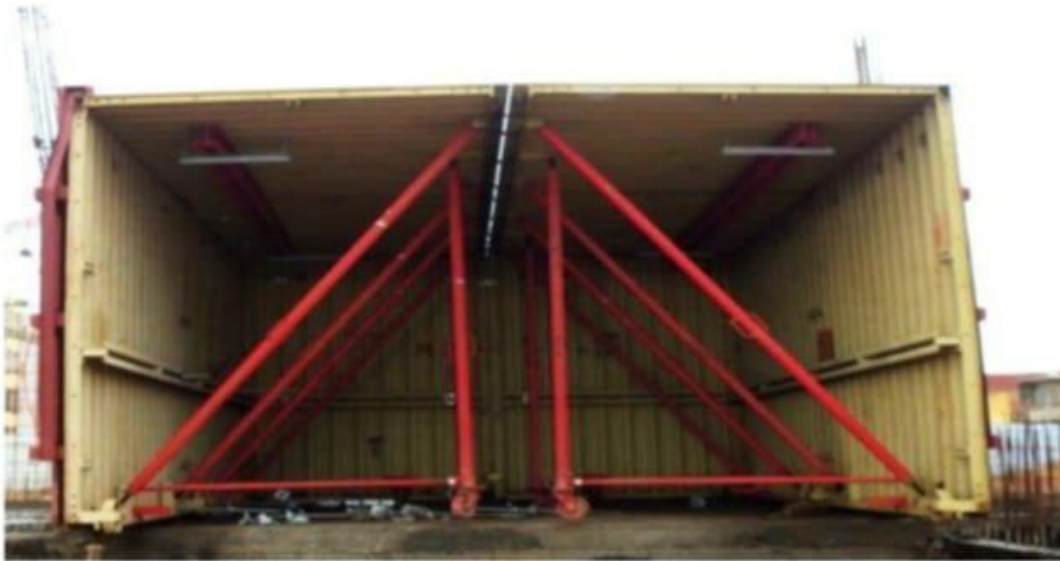
Figure 11 : assemblage des deux demi-coquilles sur chantier.
