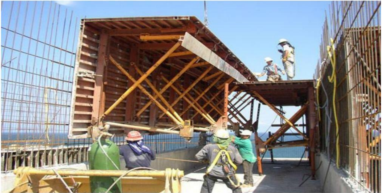
Figure 9 : une demi-coquille sur chantier.
