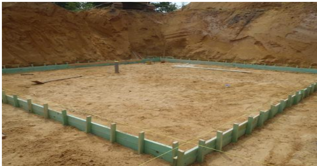
Figure 6 : les axe de la structure et Les chaise.
