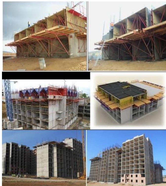
Figure 21 : technique coffrage tunnel sur chantier.
