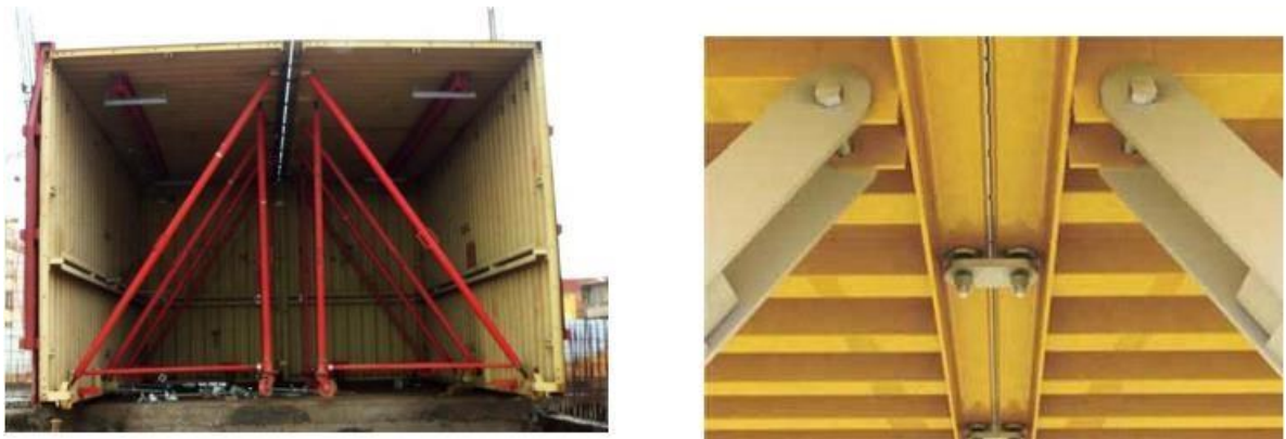
Figure 12 : assemblage des deux demi-coquilles sur chantier.
