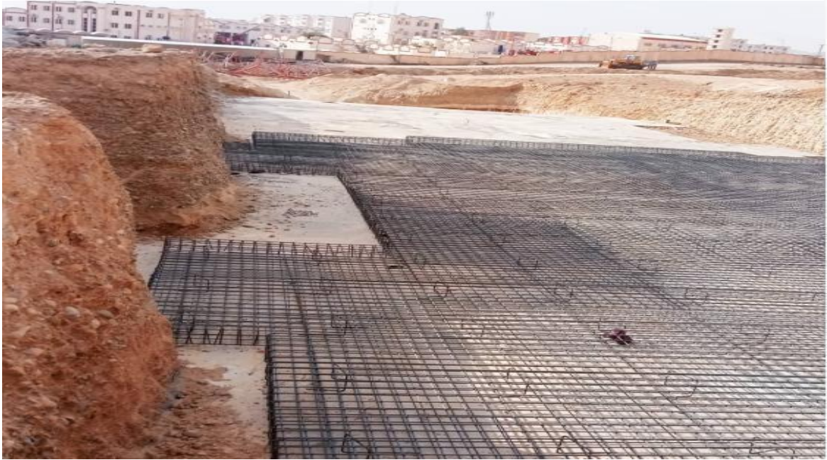
Figure 7 : Ferrailage de la semelle.
