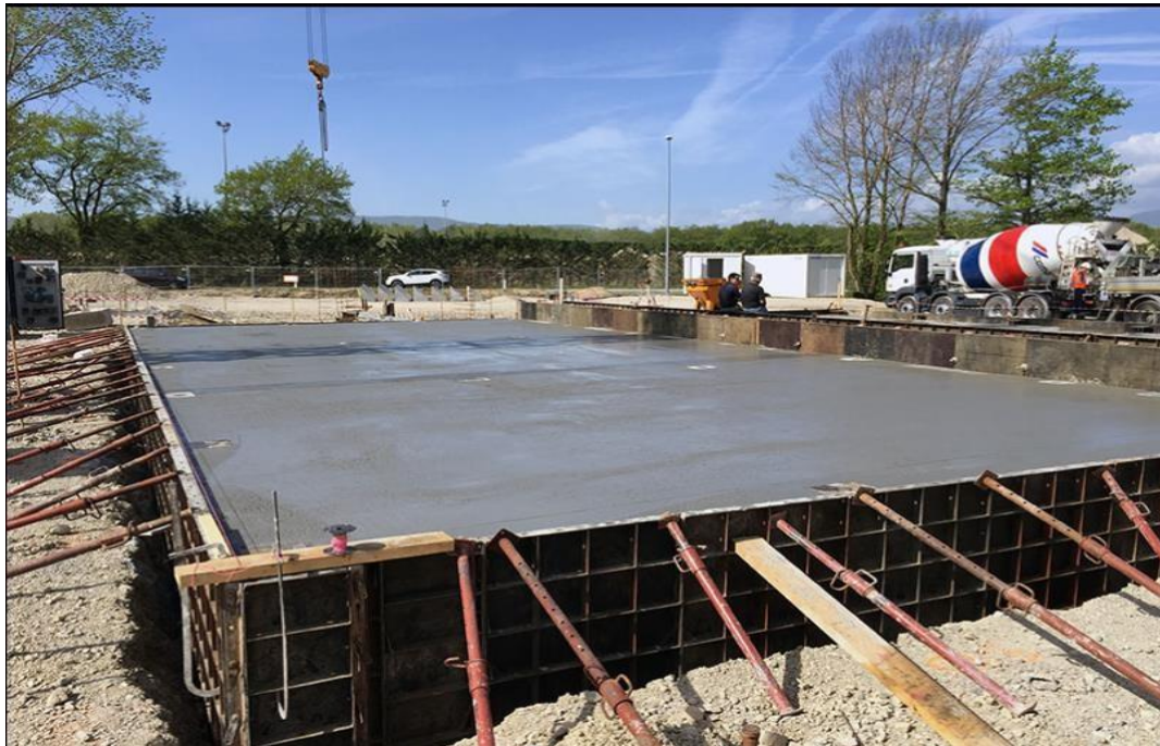
Figure 8 : coulage de la semelle.
