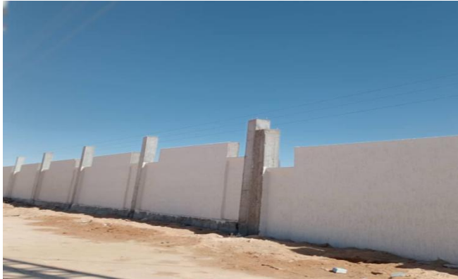
FIGURE 1. 70: Enduit au mortier ciment.
