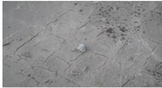
FIGURE 1. 68: Les fissures en surface de retrait.
