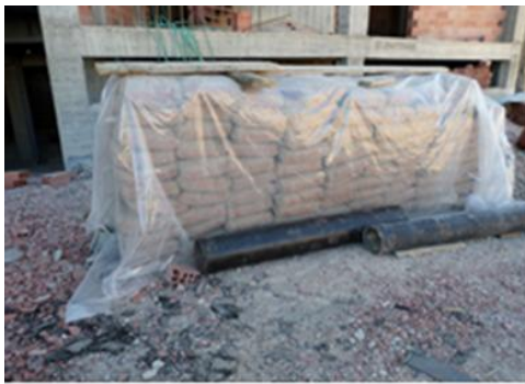
FIGURE 1. 18: Stockage de ciment en sac.
