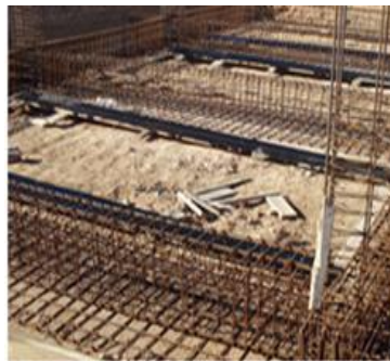
FIGURE 1. 51: Ferrailage de la poutre libag
