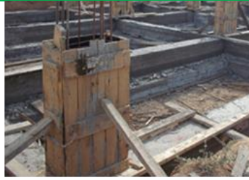
FIGURE 1. 55:Coffrage et coulage de l'amorce poteau.
