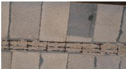
FIGURE 1. 65:La ségrégation de béton a niveau des poutrelles.
