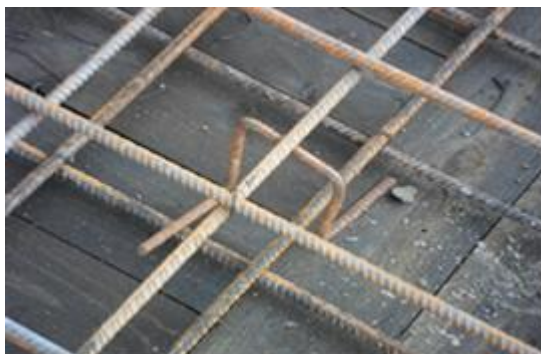
FIGURE 1. 66:Le ferrailage de la dalle pleine supérieure
