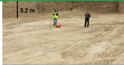
FIGURE 1. 48: mesure de la profondeur de fouille.
