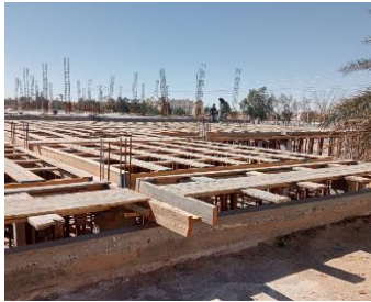
FIGURE 1. 63:Le coffrage des poutrelle
