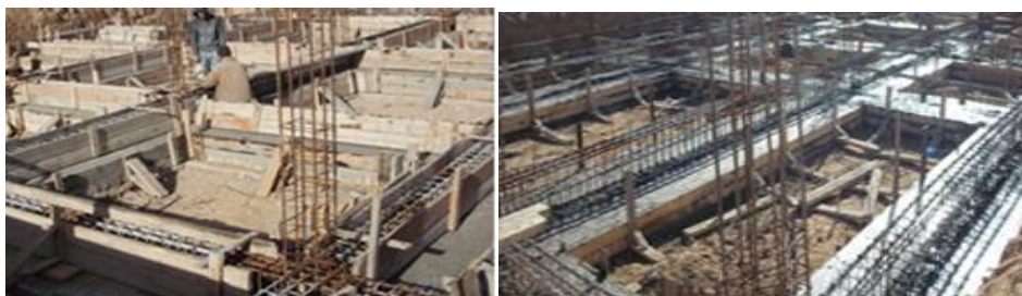
FIGURE 1. 53: Coulage de la poutre libage.
