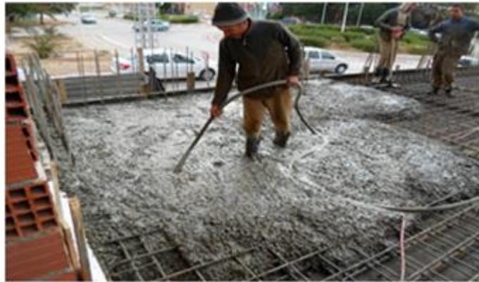
FIGURE 1. 34:Le vibreur lors de coulage.
