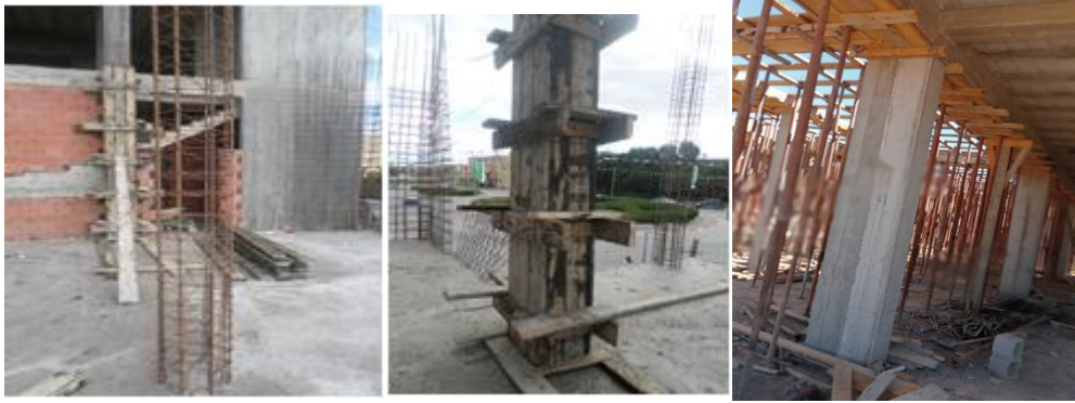
FIGURE 1. 57: Le Ferrailage FIGURE 1. 58: Le Coffrage FIGURE 1. 59: Après décoffrage
