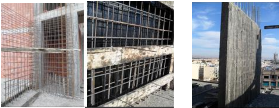
FIGURE 1. 60: Le ferrailage FIGURE 1. 61: Le coffrage FIGURE 1. 62: Le décoffrage
