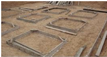
FIGURE 1. 49: Coffrage du béton propre.
