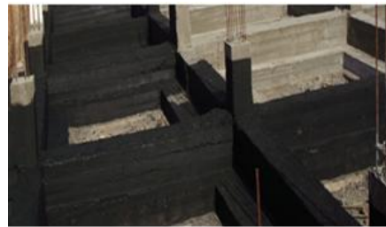
FIGURE 1. 56:badigeonnage des surfaces des fondations par le bitume
