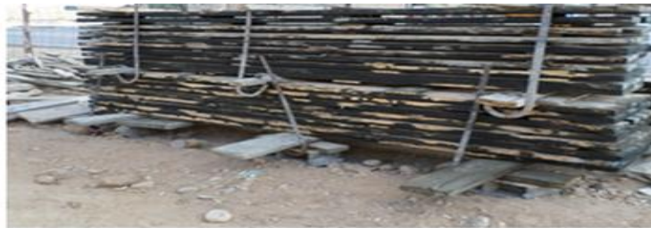
FIGURE 1. 29:Stockage des panneaux de coffrage.
