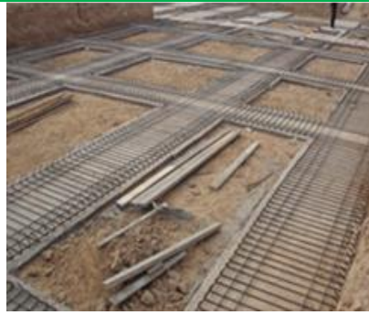
FIGURE 1. 52 Ferrailage de la semelle
