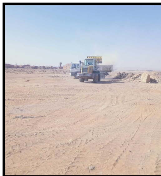
صورة 33 عملية إزالة التربة النباتية
