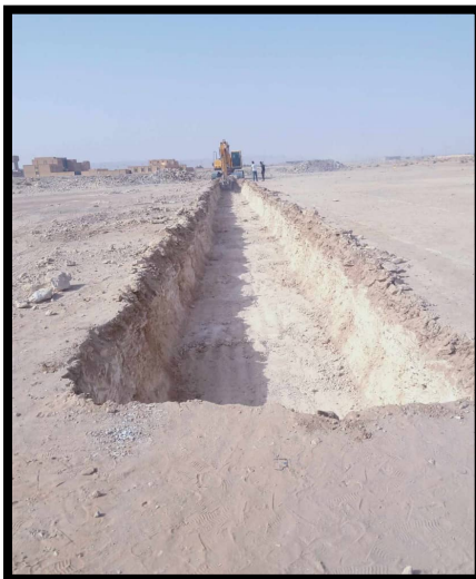
صورة 36 عملية حفر أساسات المبنى
