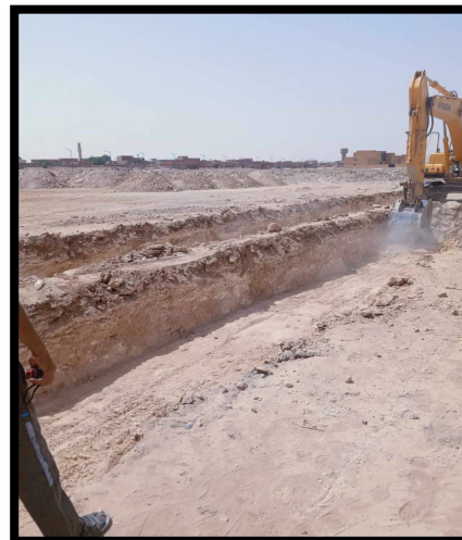
صورة 37 عملية حفر أساسات المبنى
