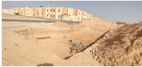
الشكل 49: حفر الاساسات على شكل حوض للمراحض
