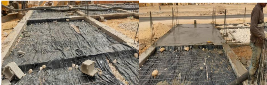
الشكل 47: صب خرسانة البلاطة العائمة
