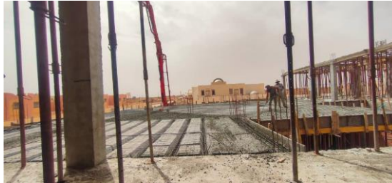
الشكل 36: عملية صب الخرسانة في الجناح البيداغوجي
