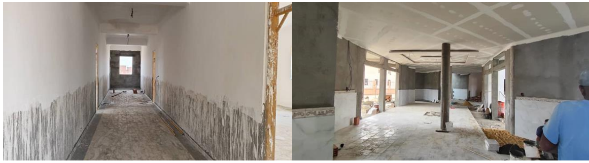
الشكل 61: انتهاء من تبليط الأرضية وتركيب الاطارات
