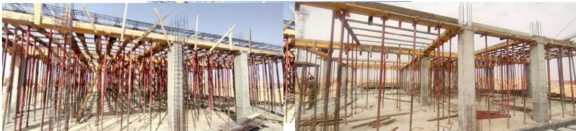
الشكل 37: عملية تخشيب السقف في الجناح البيداغوجي
