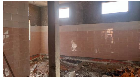
الشكل 71: تلبيس جدران المطعم بالخزف للمطبخ
