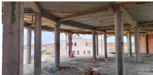
الشكل 65: نزع تخشيب سقف الطابق الاول
