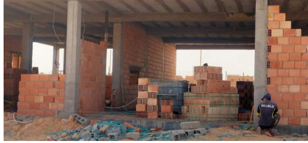
الشكل 45: بناء جدران داخلية وخارجية للمطعم
