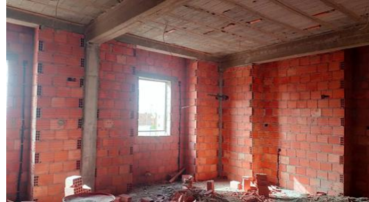
الشكل 73: نزع تخشيب الطابق الأرضي وبناء الجدران
