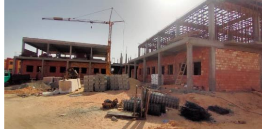
الشكل 42: تخشيب السقف وتثبيت حديد التسليح
