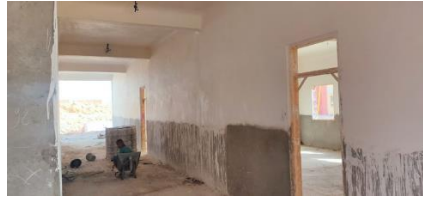
الشكل 56: تلبيس الجدران الداخلية للمطعم
