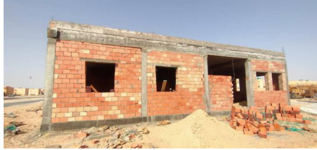
الشكل 46: الانتهاء من بناء جدران خارجية للمطعم
