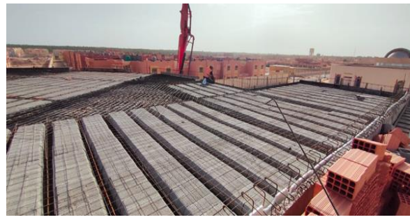
الشكل 72: صب الخرسانة المسلحة لسقف السكنات الوظيفية
