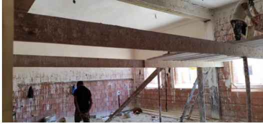
الشكل 38: عملية تلبيس الجدران الداخلية
