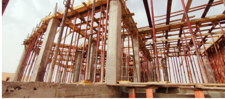
الشكل 58: تخشيب السقف
