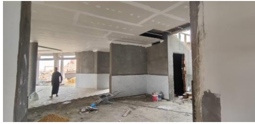
الشكل 64: انتهاء من تركيب خزف الجدران
