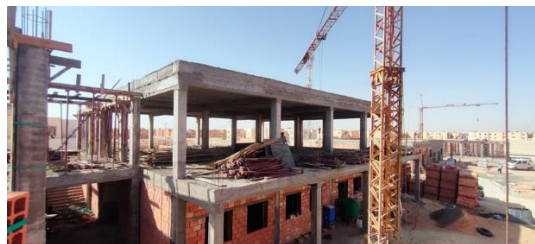
الشكل 50: صب الخرسانة المسلحة لسقف الطابق الأول للجناح البيداغوجي
