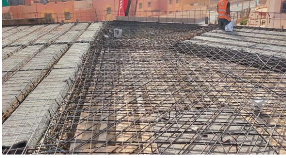
الشكل 72: صب الخرسانة المسلحة لسقف السكنات الوظيفية
