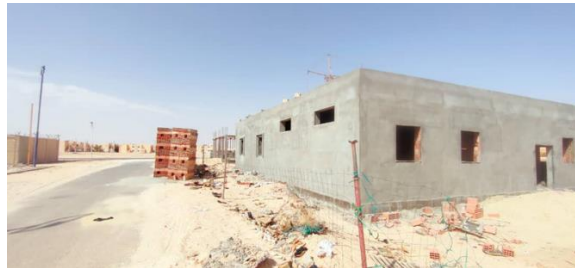
الشكل 53: تلبيس جدران الواجهة الخارجية بالإسمنت
