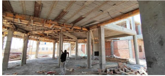
الشكل 40: نزع تخشيب السقف في الجناح البيداغوجي
