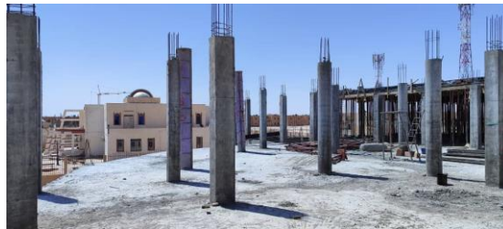
الشكل 41: إزالة تخشيب أعمدة طابق الأول للجناح البيداغوجي
