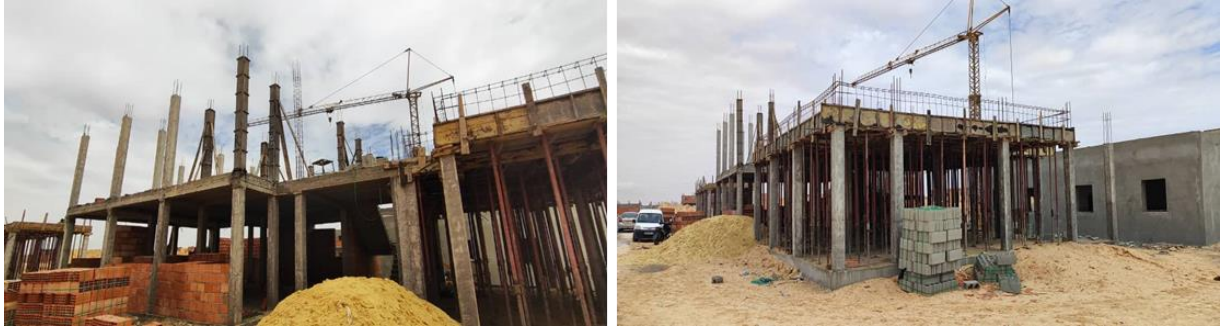
الشكل 78: عملية تخشيب السقف
