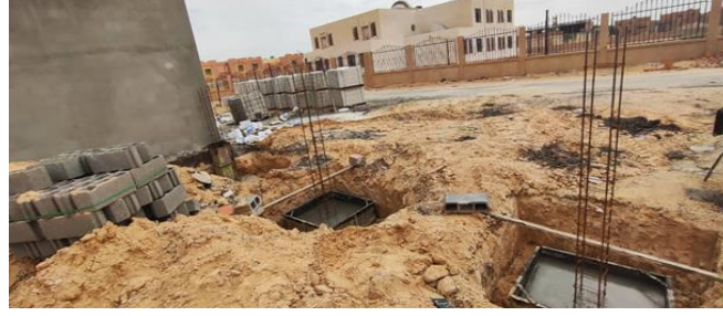
الشكل 75: صب خرسانة المسلحة لأساسات المراحيض
