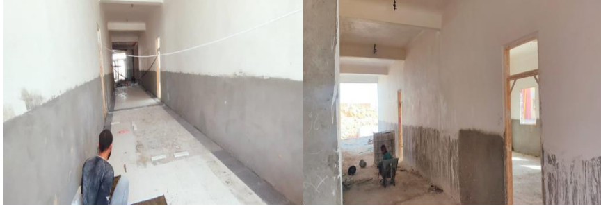
الشكل 51: تلبيس الجدران الداخلية والخارجية
