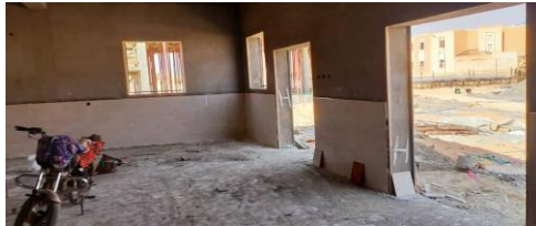
الشكل 57: تلبيس الجدران الداخلية لقاعة الاطعام بالخزف
