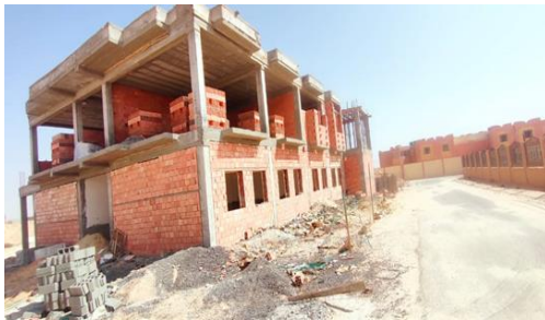
الشكل 73: نزع تخشيب الطابق الأرضي وبناء الجدران
