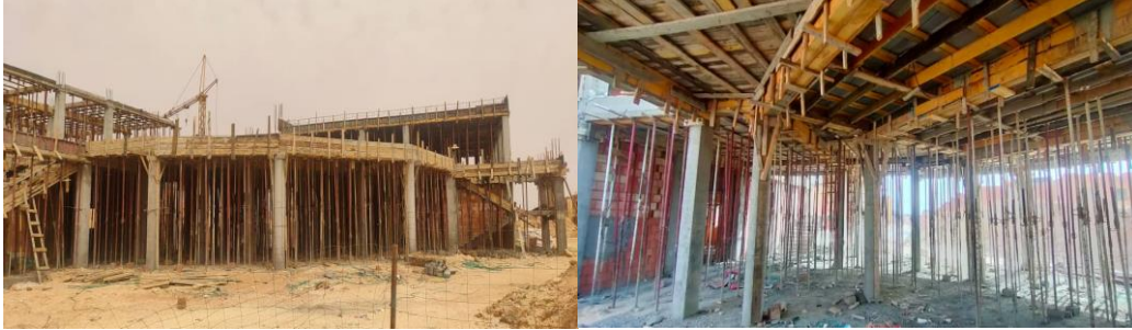
الشكل 48: تخشيب سقف الطابق الأرضي للسكنات الوظيفية
