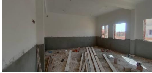
الشكل 38: عملية تلبيس الجدران الداخلية
