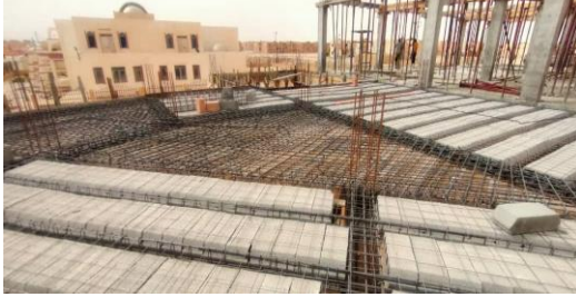
الشكل 42: تخشيب السقف وتثبيت حديد التسليح
