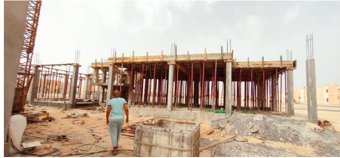
الشكل 43: نزع تخشيب السقف
