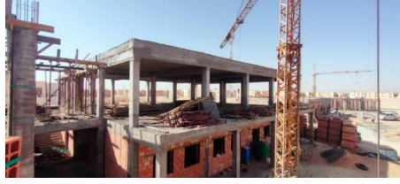
الشكل 54: تلبيس جدران الواجهة الخارجية بالإسمنت
