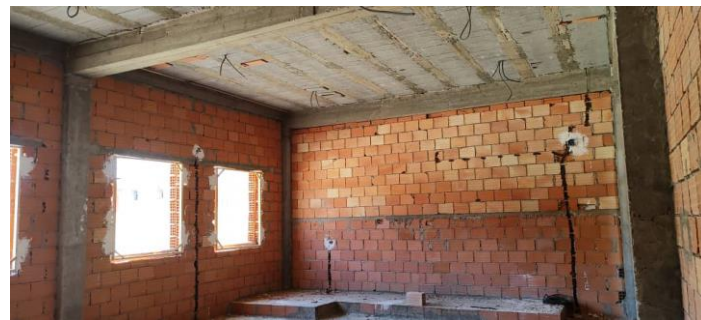
الشكل 44: اشغال الكهرباء في الطابق الارضي
