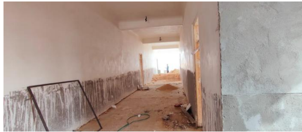
الشكل 52: تلبيس الجدران الداخلية
