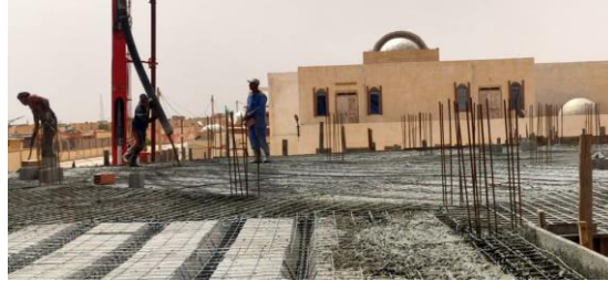
الشكل 35: عملية صب الخرسانة في الجناح البيداغوجي
