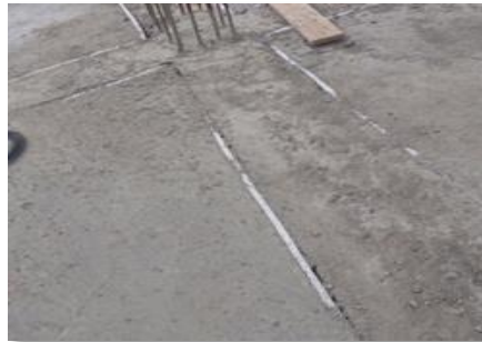
شكل III-1: يوضح إستخدام البوليستيران.
