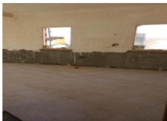
شكل III-5: يبين التلبيس بالجبس على الجدران وتحت السقف.
