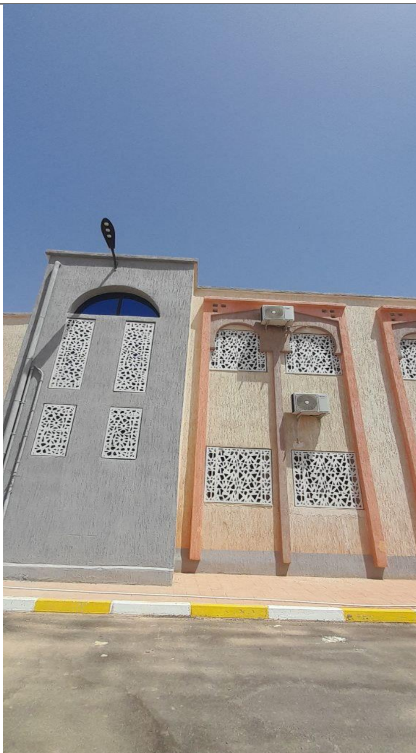
ملحق 41 الواجهات الخارجية للثانوية المصدر : الباحثة 2025
