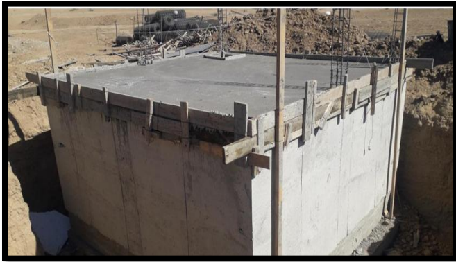
الصورة 42: عملية صب الخرسانة للخزان المائي للخزان المائي المصدر: التقرير الشهري 2023
