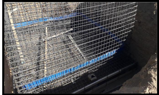
الصورة 43: قوالب و صب خرسانة الأساسات و الجدار للخزان المائي المصدر: التقرير الشهري 2023
