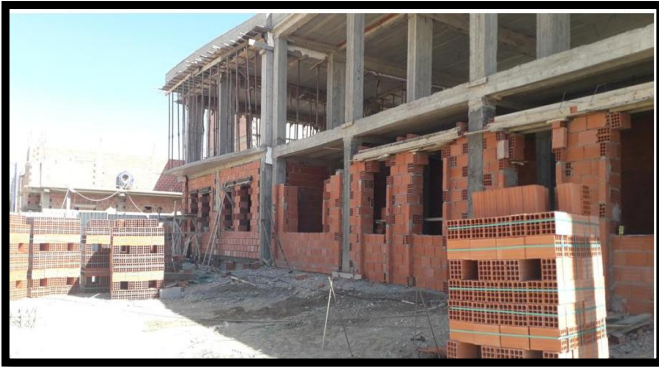
الصورة 38: بلاطات الأقسام المنتهية و بداية البناء بالأجور في الطابق الأرضي ، المصدر: التقرير الشهري 2023
