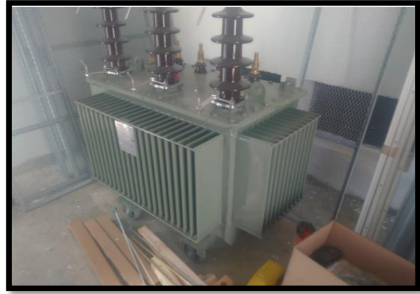
الصورة 45: عملية تركيب و تجهيز المحول ، المصدر : التقرير الشهري 2024
