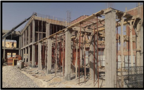
الصورة 35: بلاطة السقف في طور القولبة ، المصدر: التقرير الشهري 2023
