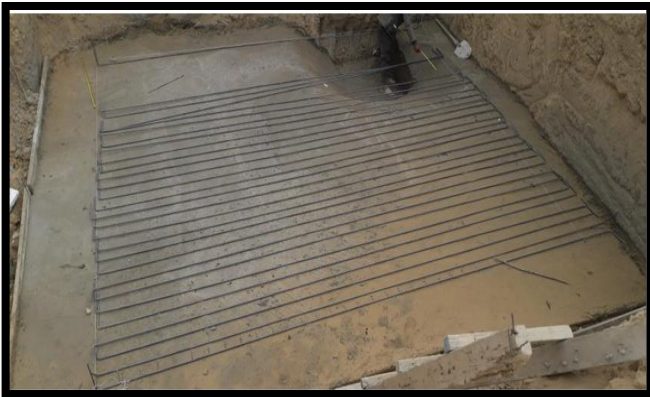
الصورة 40: عملية تسليح الأساسات للخزان المائي ، المصدر: التقرير الشهري 2023
