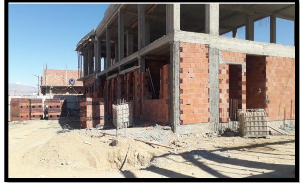
الصورة 37: بداية البناء بالأجور الأحمر بالجناحين البيداغوجي و الاداري ، المصدر : التقرير الشهري 2023
