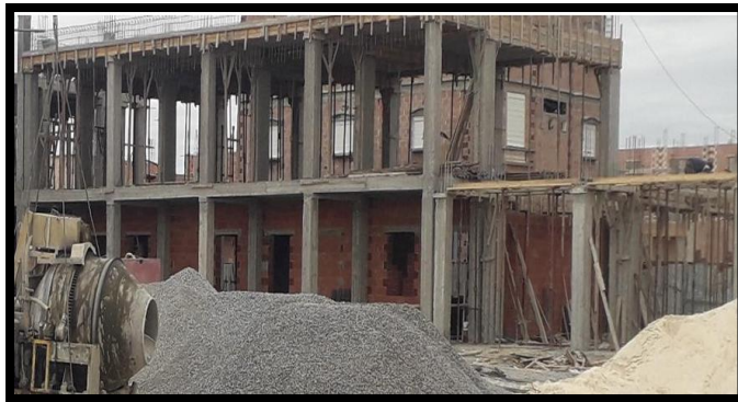
الصورة 39: بداية البناء بالأجور الأحمر بالجناح الاداري ، المصدر: التقرير الشهري 2023
