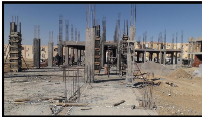
الصورة 36: أعمدة الأقسام في الجناح E04 ، المصدر: التقرير الشهري 2023
