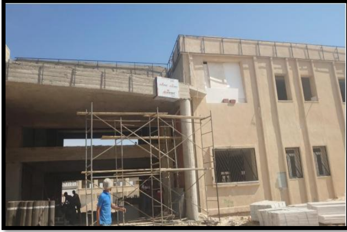
الصورة 51: انطلاق عملية تركيب صفاح التغليف للواجهة (Alicoponde) ، المصدر : التقرير الشهري 2024
