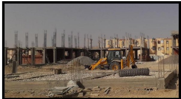
الصورة 33: قولبة و تسليح و صب خرسانة بلاطات الأسقف الجناح البيداغوجي (الأقسام) ، المصدر: التقرير الشهري 2023
