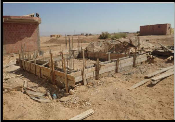
الصورة 46: عملية الانطلاق في اساسات المحول ، المصدر : التقرير الشهري 2024
