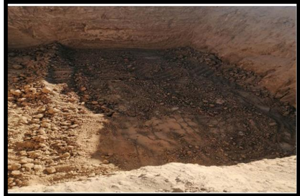
الصورة 41: عملية حفر الأساسات للخزان المائي ، المصدر: التقرير الشهري 2023
