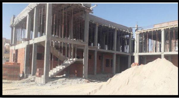
الصورة 32 : صب خرسانة بلاطات الأسقف ، المصدر: التقرير الشهري 2023
