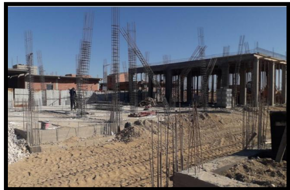
الصورة 34: أعمدة الجزء الثاني للنصف الداخلي ، المصدر: التقرير الشهري 2023
