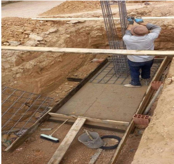
صور 42 تبين عملية صب خرسانة الاساسات المصدر: مكتب الدراسات
