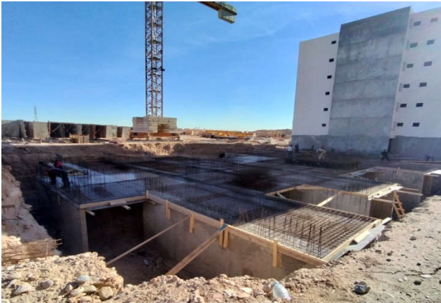
الشكل 3-8: القيام بوضع قولبة و التسليح الخاص بالسقف السفلي و صبه
