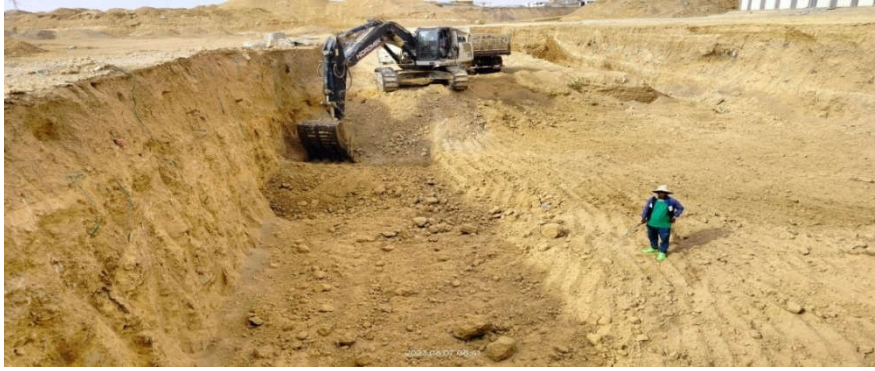
الشكل 3-1: القيام بحفر الحفر الخاصة بالأساسات
