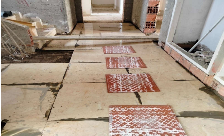
الشكل 3-12: تركيب البلاط الخاص بالأرضية
