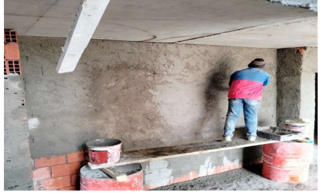
الشكل 3-11: القيام بتلييس الجدران بالإسمنت و الجص
