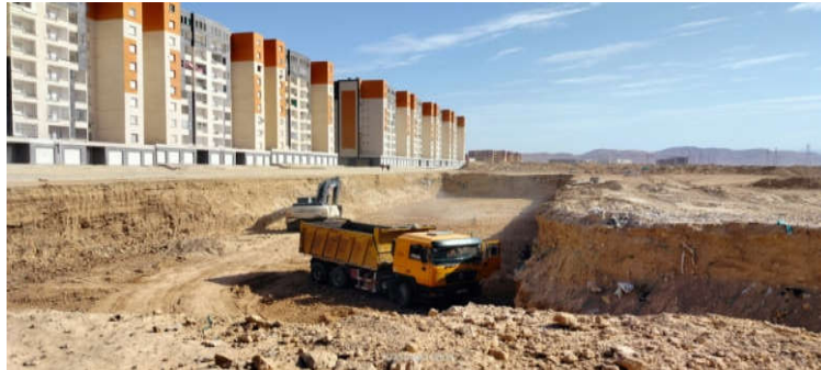
الشكل 3-2: القيام بإخراج التربة من الحفرة / المصدر : الباحث ( 2025 )
