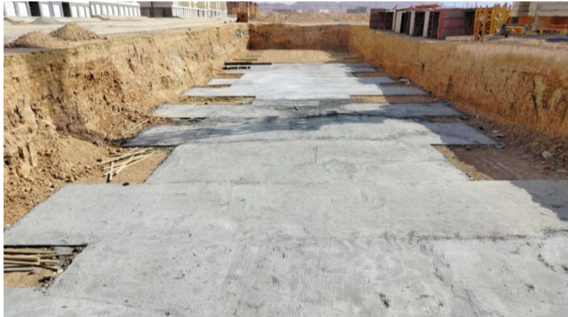
الشكل 3-4: القيام بصب خرسانة النظافة لأرضية
