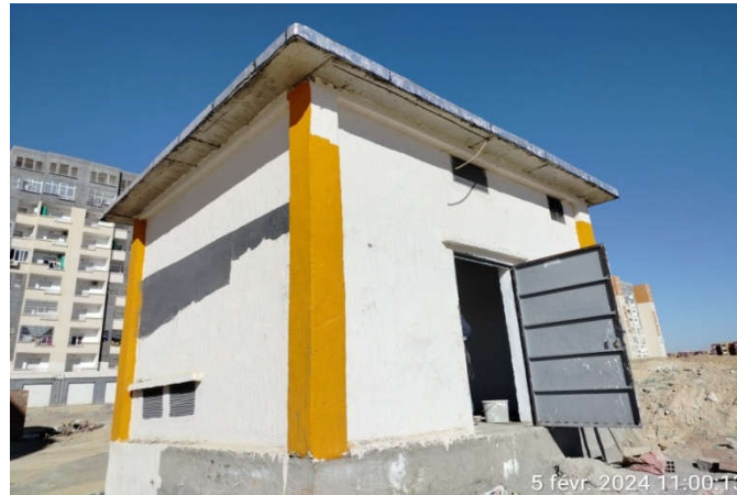
الشكل 3-14: بناء غرفة الكهرباء لتزويد العمارة بالكهرباء اللازمة
