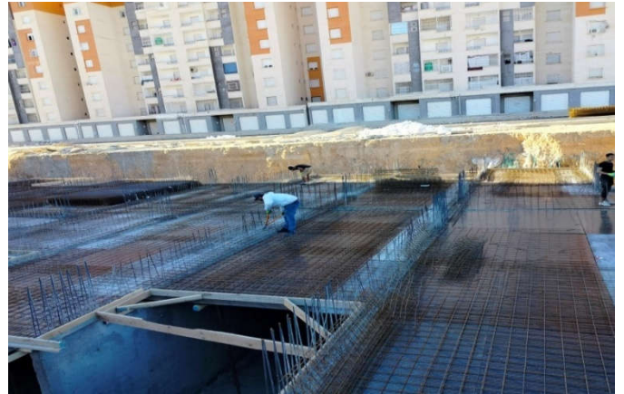
الشكل 3-8: القيام بوضع قولبة و التسليح الخاص بالسقف السفلي و صبه
