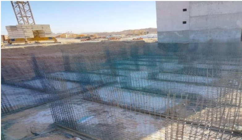
الشكل 3-6: القيام بتنشيت التسليح الخاص بالجدران الخرسانية .
