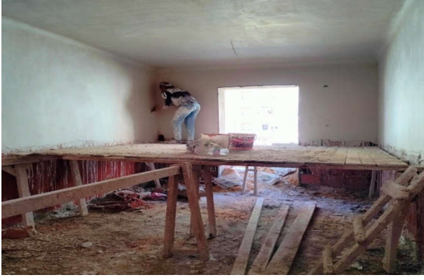
الشكل 3-11: القيام بتلييس الجدران بالإسمنت و الجص
