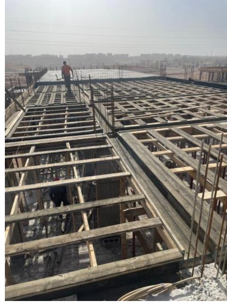
ورشة البناء 4 صورة لداخل ورشة البناء
