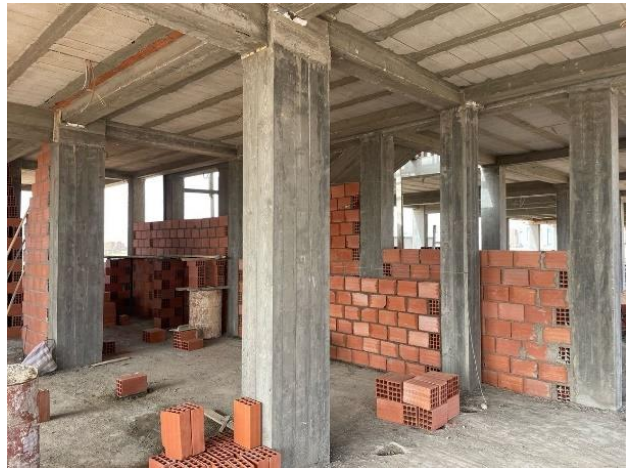
ورشة البناء 7 صورة لداخل ورشة البناء
