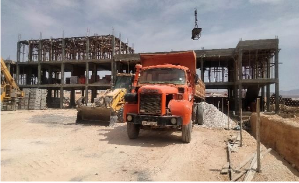
ورشة البناء 9 صورة لداخل ورشة البناء
