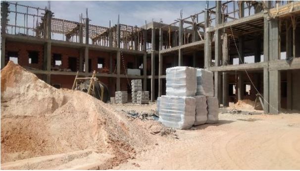
ورشة البناء 10 صورة لداخل ورشة البناء
