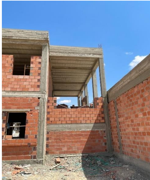
ورشة البناء 6 صورة لداخل ورشة البناء
