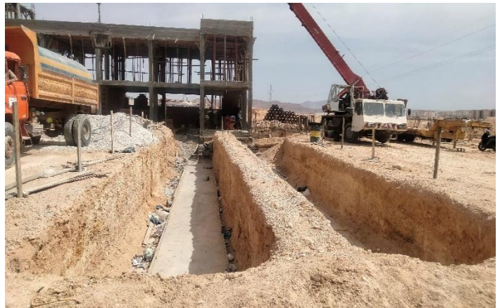
ورشة البناء 8 صورة لداخل ورشة البناء
