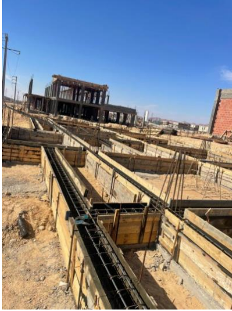
ورشة البناء 5 صورة لداخل ورشة البناء
