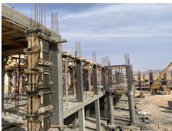
ورشة البناء 1 صورة لداخل ورشة البناء
