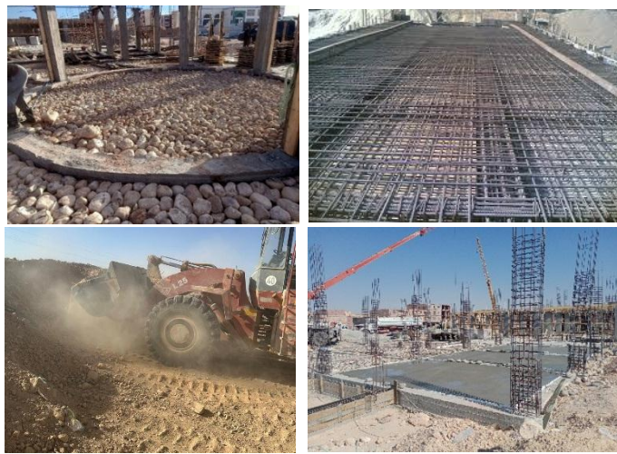
الشكل 6.3: أشغال تسليح البلاطة الخاصة بالثانوية المصدر: مؤسسة الإنجاز شيخ نوري بسكرة، 2025
