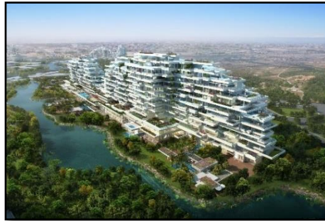
Figure 51 : Vue aérienne du projet.
