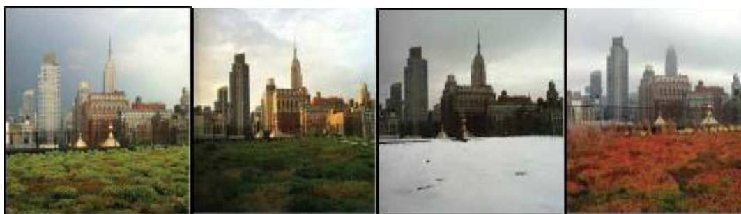
Figure 8 : Le toit végétalisé des bureaux des Architectes COOKFOX à New York.
