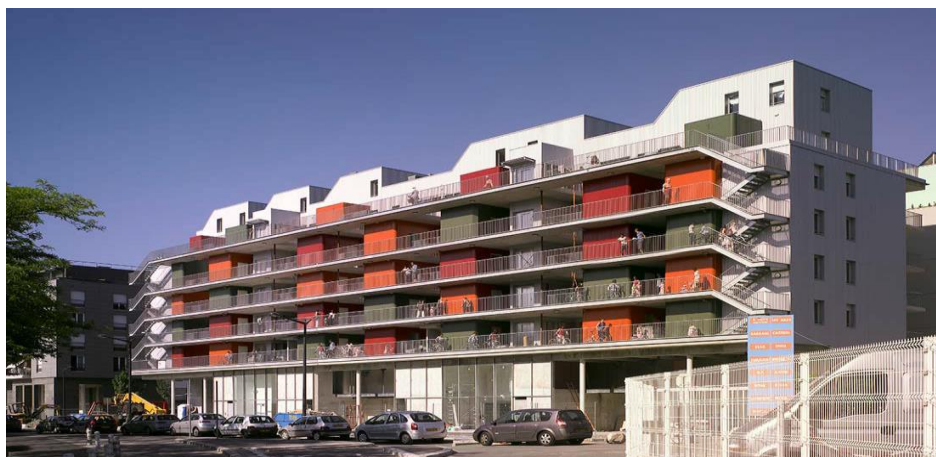
Photo 09 : Immeuble à cousives
