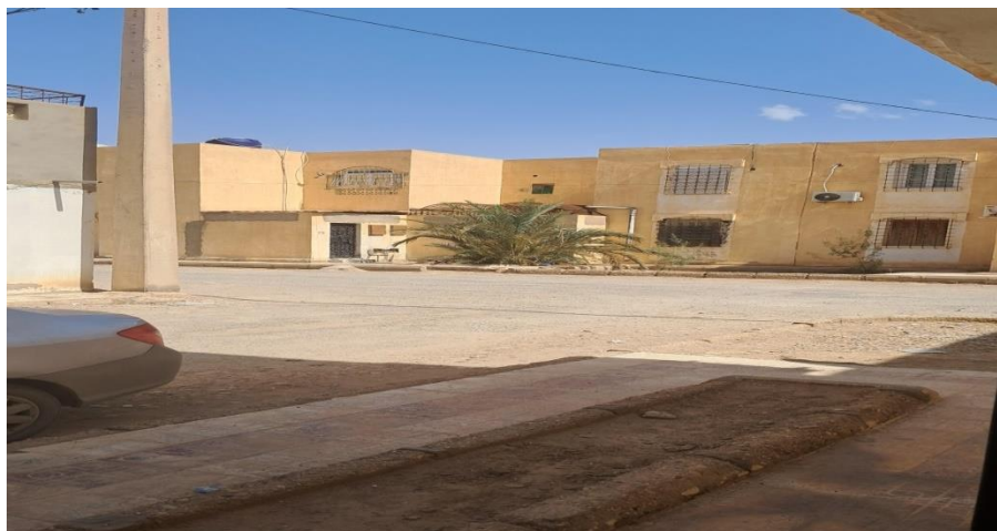
Photo 3 : Maisons semi collectif 350 logements Source: Auteur 2025
