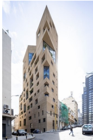
Figure 34: Immeuble d'appartements Stone Garden. Source: Arch Daily
