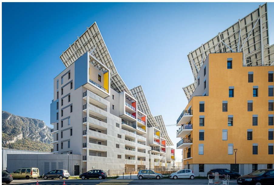
Figure 3: Bâtiment de ABC en France. Source : https://www.construction21.org/france/case-studies/h/abc-building .
