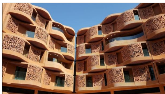
Figure 73: Façade des logements de quartier.
