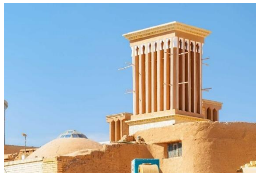
Figure I.4 : tour à vent (badgir)
