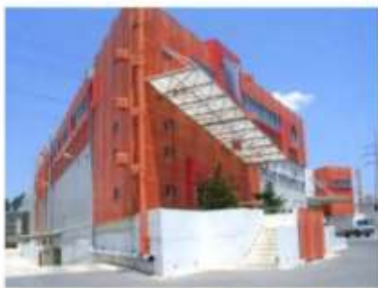
Figure 19: Vue extérieure du bâtiment de l'entrepôt de papier Aggelidis. Source: Use of Earth to Air Heat Exchangers for Cooling.pdf
