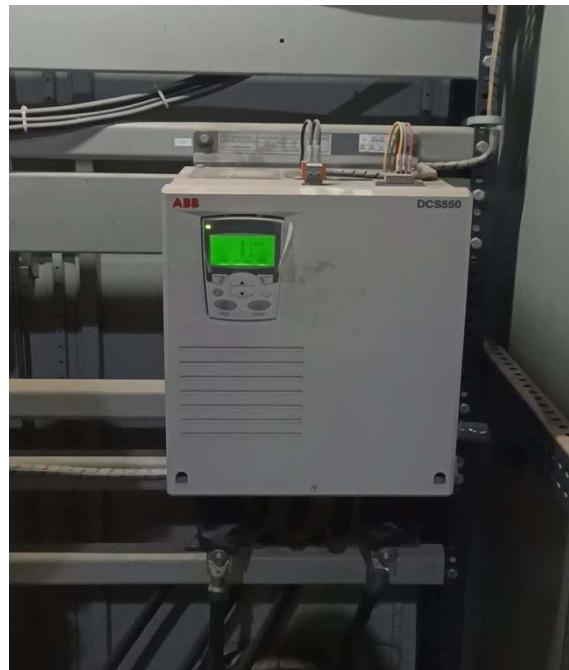
Figure II.13 : Variateur de vitesse ABB DCS550-S01-0225.
