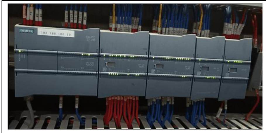
Figure III.10 : Automate S7-1200 avec ces modules.
