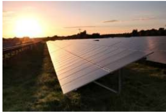
Figure III.21: Défaut de vent
