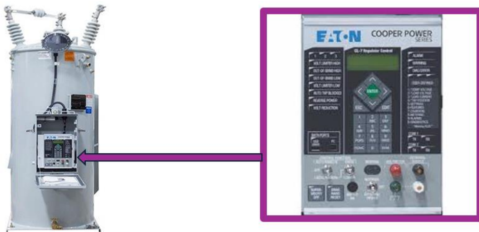
Figure II.7 : Installation d'un régulateur de tension avec le transformateur de distribution.
