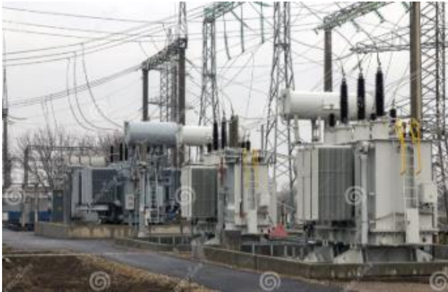
Fig. II-10- Transformateurs de tension TP
