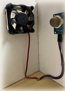
Figure III.83 Installation du capteur de gaz près du ventilateur
