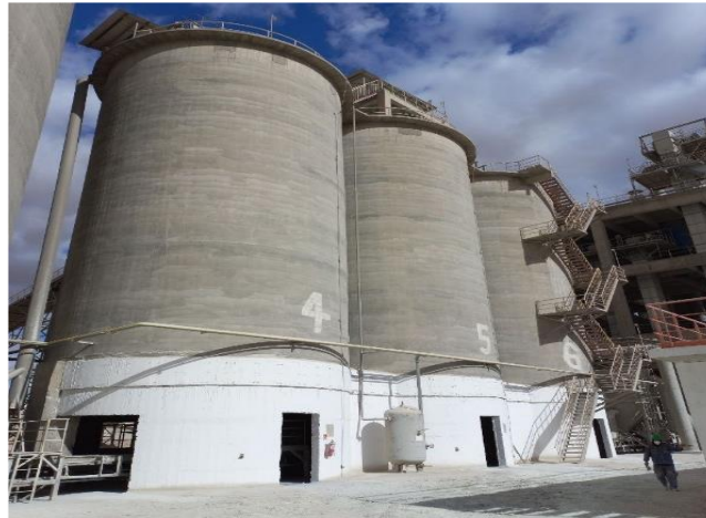
Figure I.26: Les silos de stockage du ciment [4].
