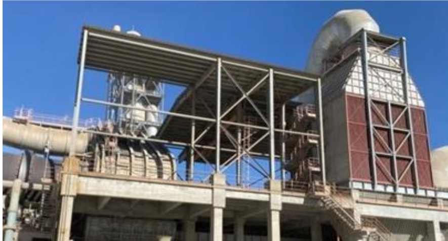
Figure I.22 : Refroidisseur [12]
