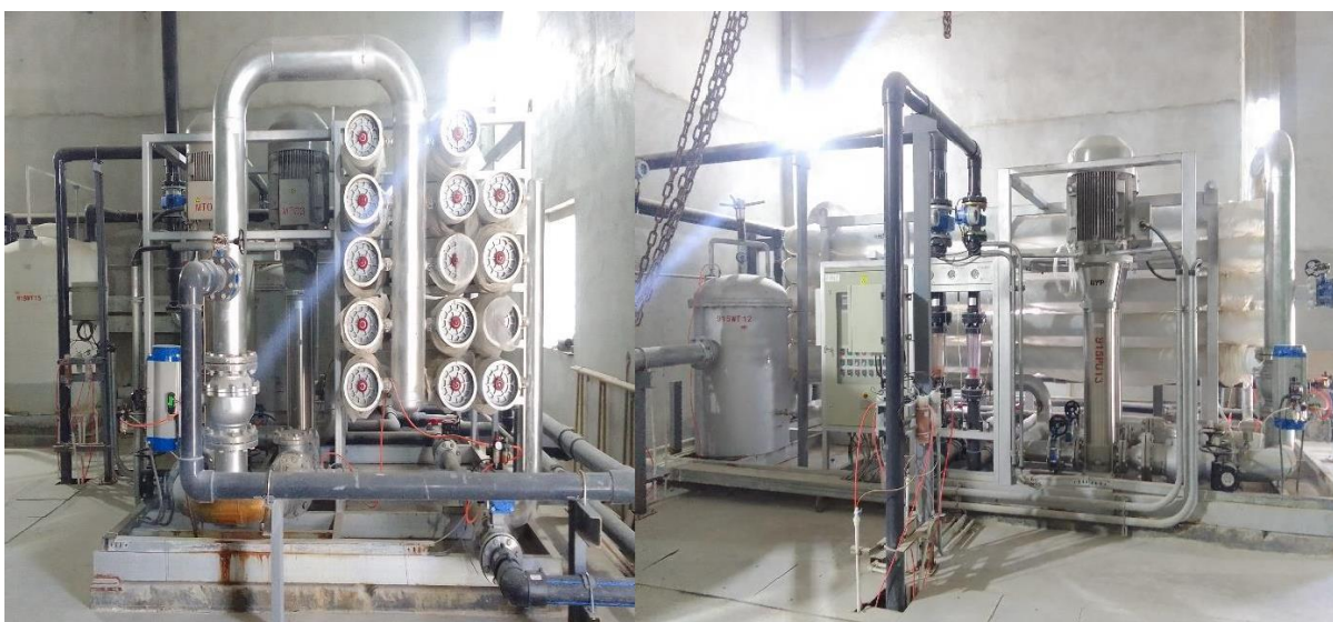
Figure II. 7 : Les membranes dans la station d'osmose SPA
