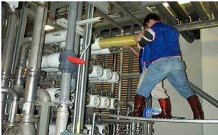
Figure II.13 : Remplacer l'élément membranaire d'osmose inverse
