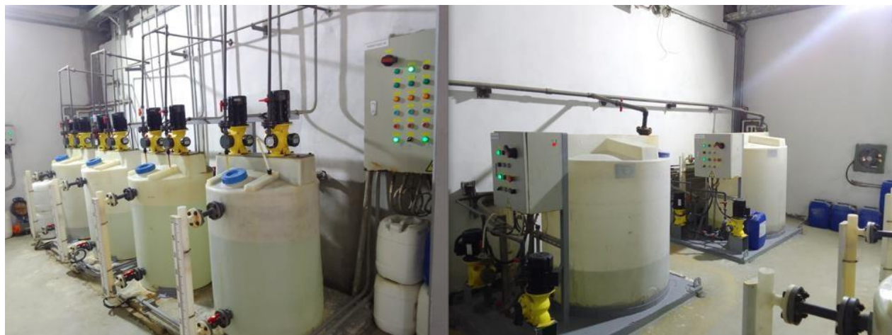
Figure II.12 : Système de nettoyage en place par osmose inverse (SPA)
