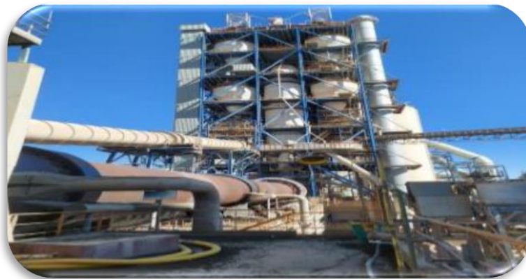
Figure I-14 : Four rotatif et préchauffage [20].
