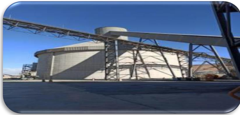
Figure I.15 : Silo du clinker [9].
