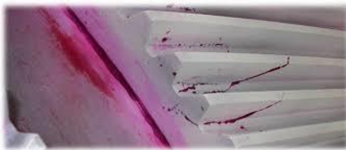
Figure II. 8 : Fissuration détectée par pénétrant coloré
