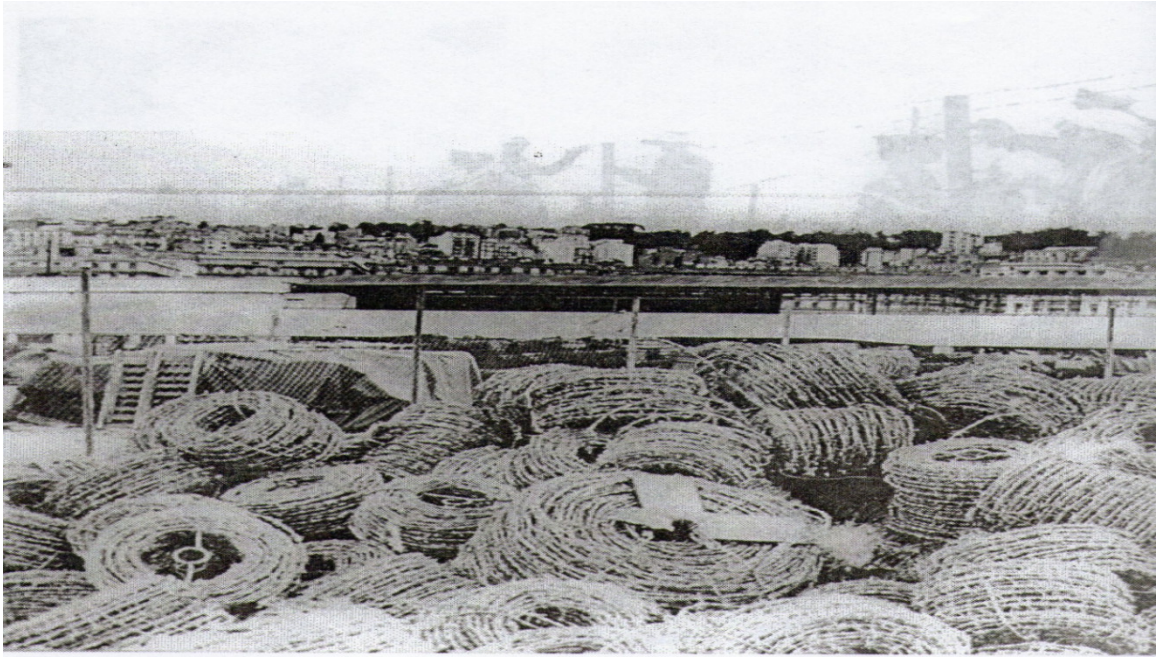
عملية إنزال الأسلاك الشائكة بمناء الجزائر للمشروع في عملية الإنجاز
