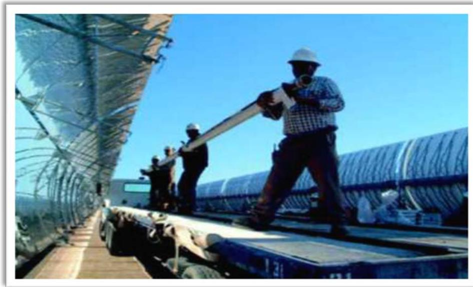
**Figure I.16:** Montage d'un élément de récepteur tubulaire sur un capteur cylindro-paraboliques.
