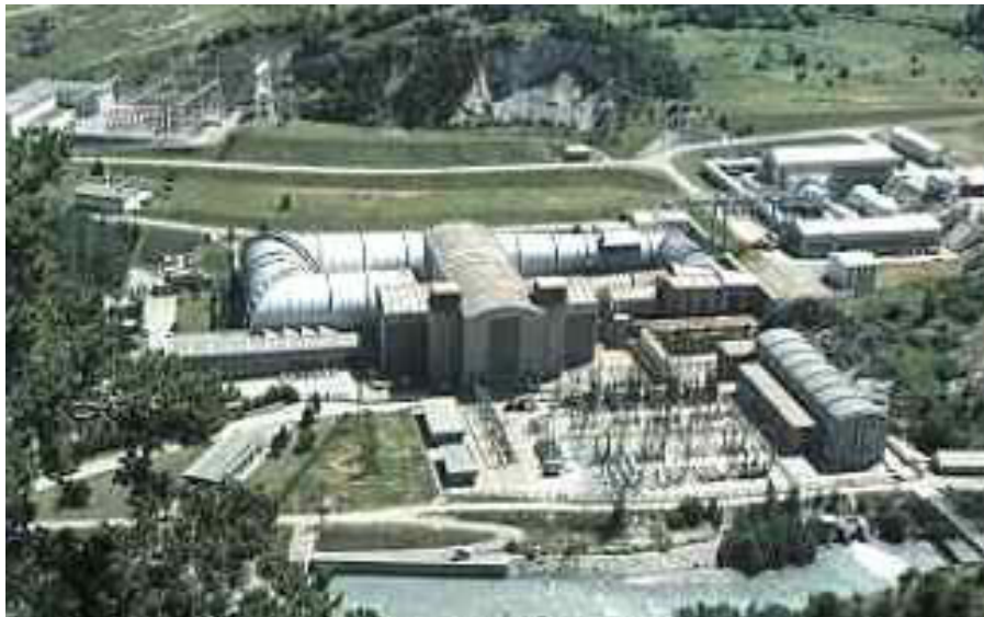
Figure (I.3) : Centre de Modane-Avrieux [4].
