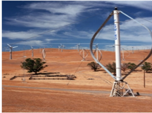
Figure 1.9 : Éolienne Darrieus du constructeur américain Flowind d'un diamètre de la turbine 19 m et une puissance de 170 KW [3]
