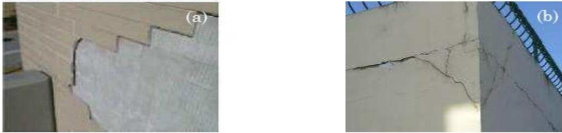
**Figure II.13** : Conséquences d'une perte d'eau importante (a) perte d'adhérence et (b) fissuration. [19]
