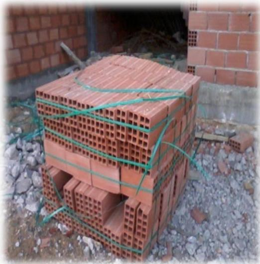
Fig. I.23: Briques creuse
