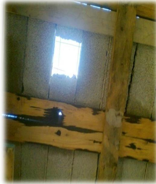
Fig. I.47: mauvaise réalisation Des planchers
