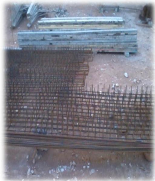
Fig.I.45: Ferrailage de poutrelle.
