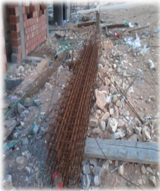
Fig. I.40: ferrailage de poutre.
