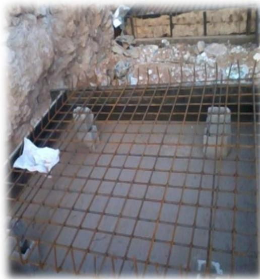
Fig. I.27: mise en place de ferrailage
