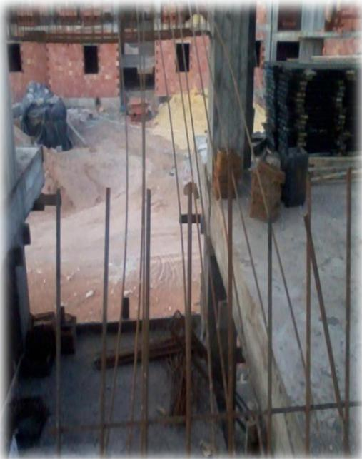
Fig. I.48: le ferrailage d'un escalier.
