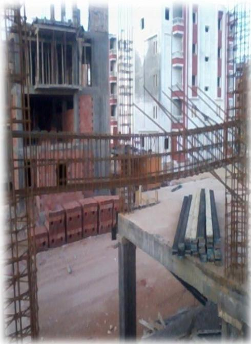
Fig.I.51: ferrailage de la poutre palière.
