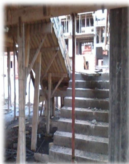
Fig.I.49: Le coffrage d'un escalier.
