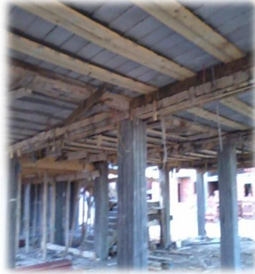
Fig. I.44: coffrage de plancher
