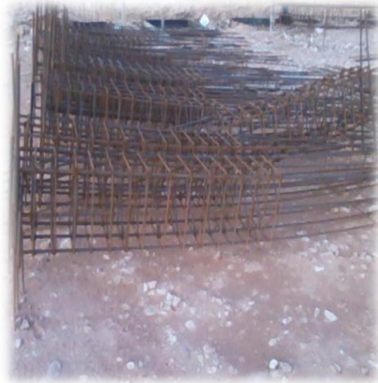
Fig. I.29: ferrailage des amorces poteaux
