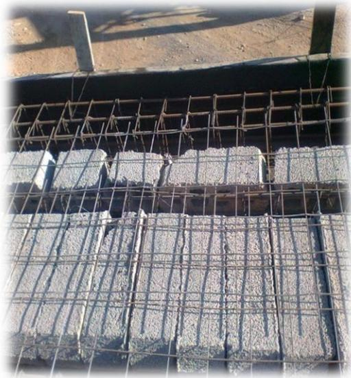
Fig. I.43: ferrailage des planchers
