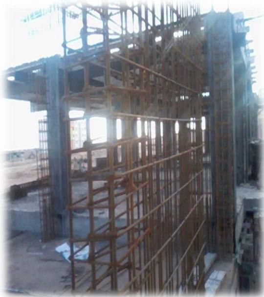
Fig. I.38: ferrailage des voiles
