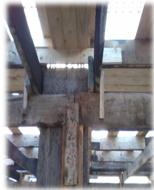
Fig. I.41: coffrage des poutres.
