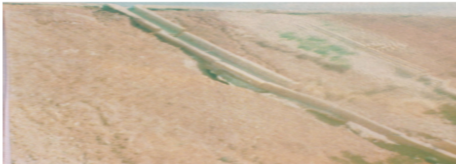
Photo iv-5 : Rupture des descentes d'eau.
