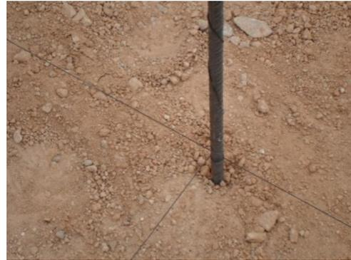
Après avoir complété et réglé les axes, nous traçons les lignes limites avec les dimensions de chaque semelle, on trace aussi les axes des semelles sur le terrain de projet conformément au plan de fondations :
