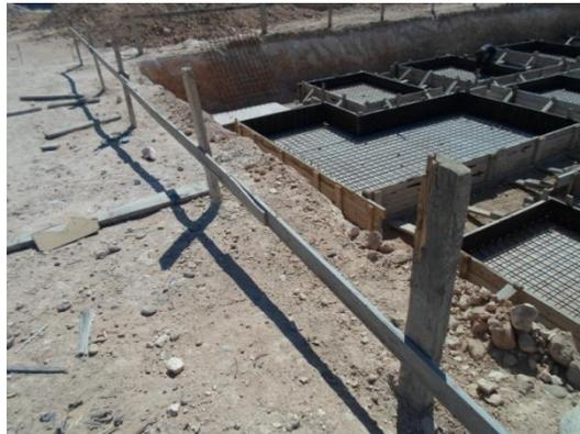
Ici, il faudra faire attention au respect des distances d'enrobage, on utilise pour cela des morceaux solides de béton ou des chutes de carrelage ; mais ces chutes ne peuvent pas être bien coller avec le béton, donc, nous recommandons l'utilisation des morceaux spéciaux fait de béton léger pour être une bonne adhérence à elle de la même matière :
