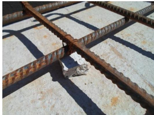
Après la pose des armatures de semelle, vient l'étape de pose des armatures des amorces poteaux, ensuite on place le coffrage.
