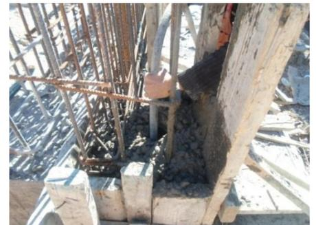
**12- Enduire les semelles et les amorces poteaux de bitume d'étanchéité :** On procède à l'opération de revêtement par des substances liquides spéciales, qu'on peut assimiler à de la peinture, c'est une opération en deux phases. Dans la première phase, on doit enduire de peinture à base de poudre qui s'appelle le flintcoat, ce qui contribue à l'adhérence de la deuxième couche avec la surface de semelle. La seconde phase à peindre est une
