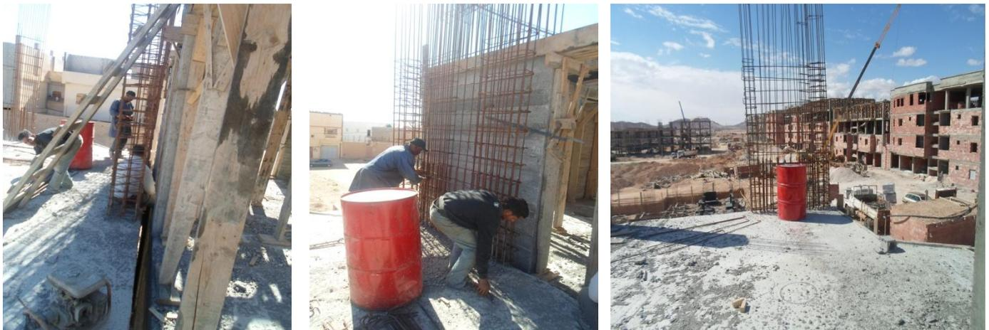
**1-2- Coffrage :** être a couvriez l'armature des poteaux et voiles couverture entièrement en ce qui concerne l'enrobage et la verticalité de poteaux ou voile par le fille de plomb ; en ce qui concerne les dimensions de la section et la position
