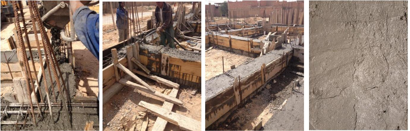
Pour les travaux de réalisation de l'escalier, nous notons aussi les barres d'attentes du ferrailage étaient abandonné sans un support au-dessous et l'intention ici au début de prise de béton générer matériel est responsable de bonne adhérence sur béton avec des barres d'armature ; cela peut conduire à déplacer les barres en raison du vent ou de contact avec les travailleurs.
