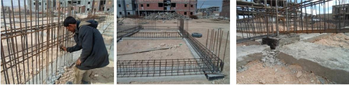
**Remarque :** Pour la photo à droite ; notez qu'on n'a pas respecté le niveau de amorce poteau, il s'agit d'une mauvaise réalisation
