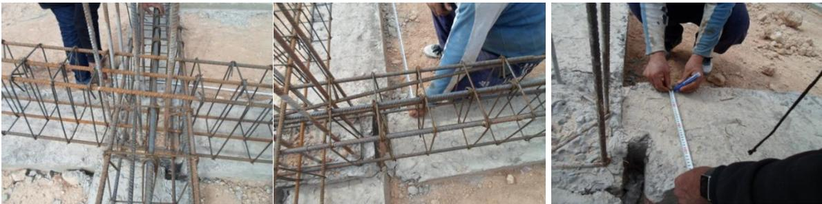
Et ici notez que les ouvriers ont coupé les plaques des coffrages en utilisant la machine de cisaillement (la cisaille) et ont coffré les longrines :
