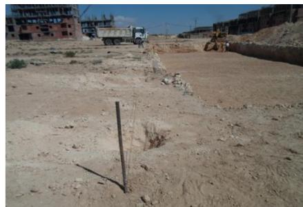
Après avoir fixé les chaises dans le sol, on enfonce des clous dans le sol en des points mesurés à l'aide d'un appareil topographique, celui-ci peut être un « niveau topographique » ou « le théodolite ». On lie les clous par du fil d'attache, pour permettre de transférer les données des plans de fondations sur le terrain réel des fondations ; cela représente sur terrain les axes de référence du bâtiment indiqués sur les plans du dossier d'étude.
