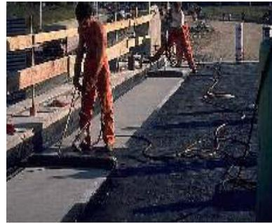
**Figure. I.13:Etanchéité par feuille préfabriquée monocouche**
