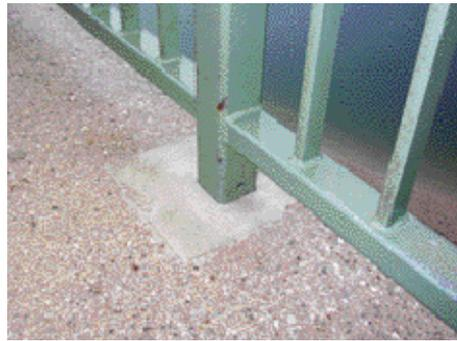
**FigureII.12 : trou de drainage dans la partie inférieure d'un profilé creux.**
