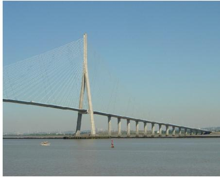
**Figure. I.9: pont de Normandie (pont haubans)**
