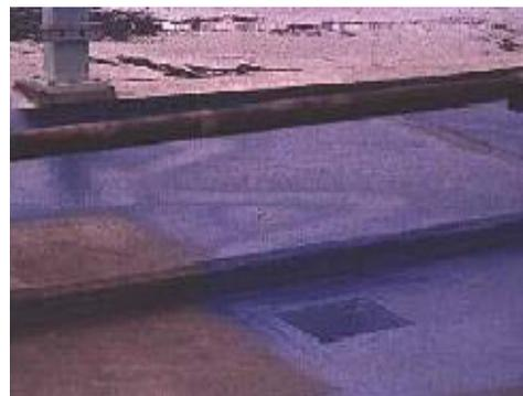
**Figure. I.15:Etanchéité de type SEL ou FMAS.**
