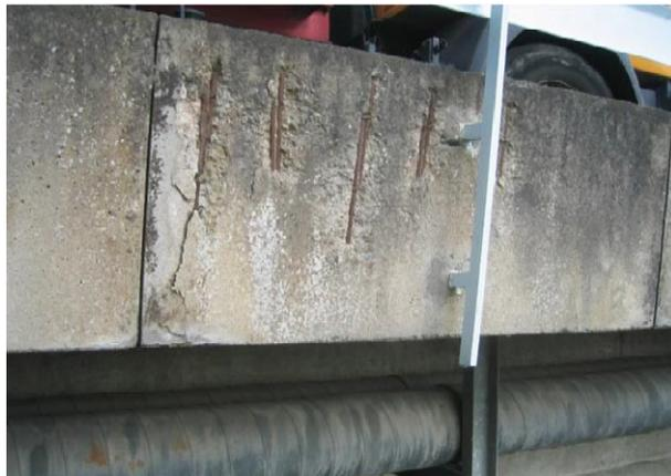
**Figure II.5 : suite au gel et à l'insuffisance d'enrobage des aciers pour les corniches en BA.**
