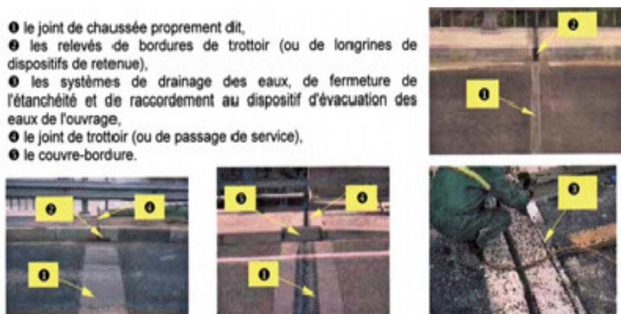
Figure I.34 : Composition d'un «kit» de joints de chaussée d'un pont routier.
