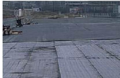
**Figure. I.14:Etanchéité par feuille préfabriquée + Asphalte.**
