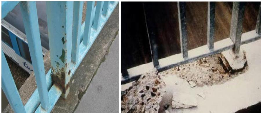
**Figure II.6 : Fixation défectueuse.**
