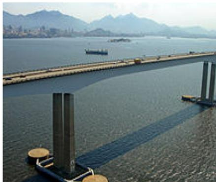
**Figure. I.6 : Pont Rio-Niterói - Rio de Janeiro - Pont à poutres métalliques**
