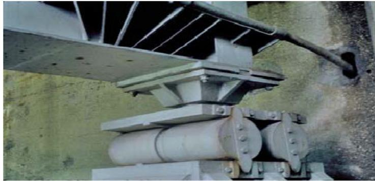
**Figure I.22: Un bel exemple d'appareil d'appui métallique combinant un système à rouleaux Pour les déplacements et une rotule pour les rotations.**
