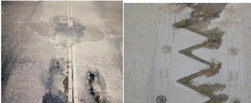
**Figure II.8 : détérioration due au passage des véhicules.**
