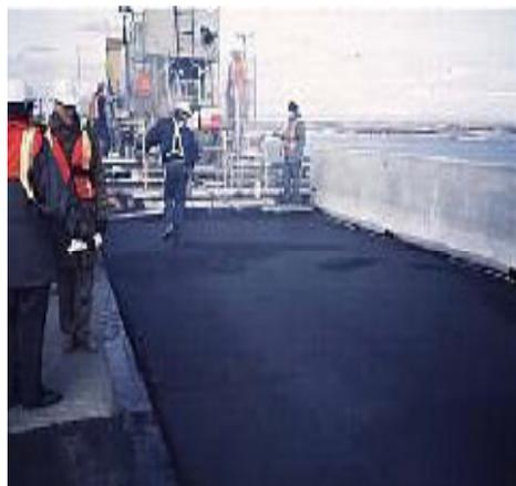
Figure. I.16:Etanchéité par procédés MHC.
