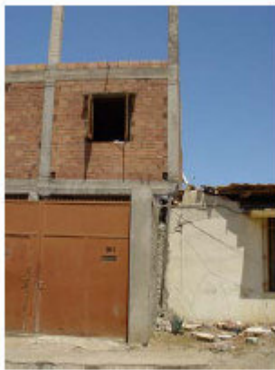
Fig. 10.10 Absence de joint entre le bâtiment « souple » à gauche et le bâtiment rigide à droite
