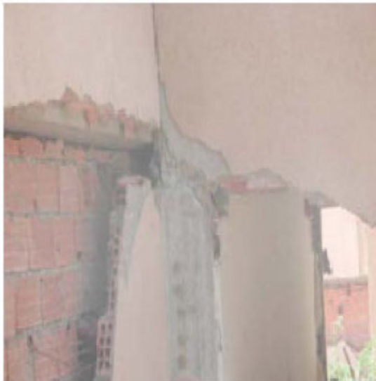
Mur de remplissage extérieur en double paroi de 10cm+10cm(vide)+10cm
