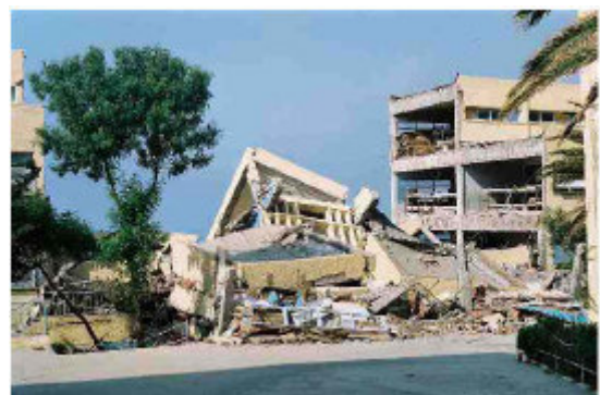
Photo 16. Insuffisance d'armatures transversales en zone critique
