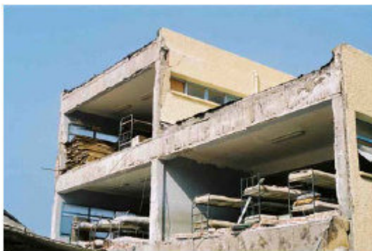
Fig. 10.10 Absence de joint entre le bâtiment « souple » à gauche et le bâtiment rigide à droite
