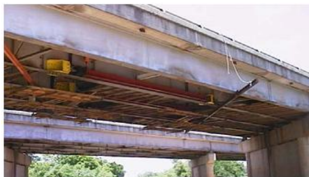
Figure 2.33 : Amortisseur à orifice variable [50]
