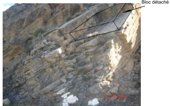
Massif discontinu : failles, diaclases, plans de stratification, remarquer bloc détaché
