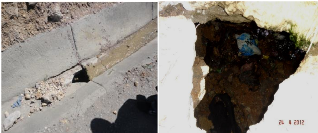
Photo VI.10 : Cavités sous la chaussé due à la dissolution des gypses
