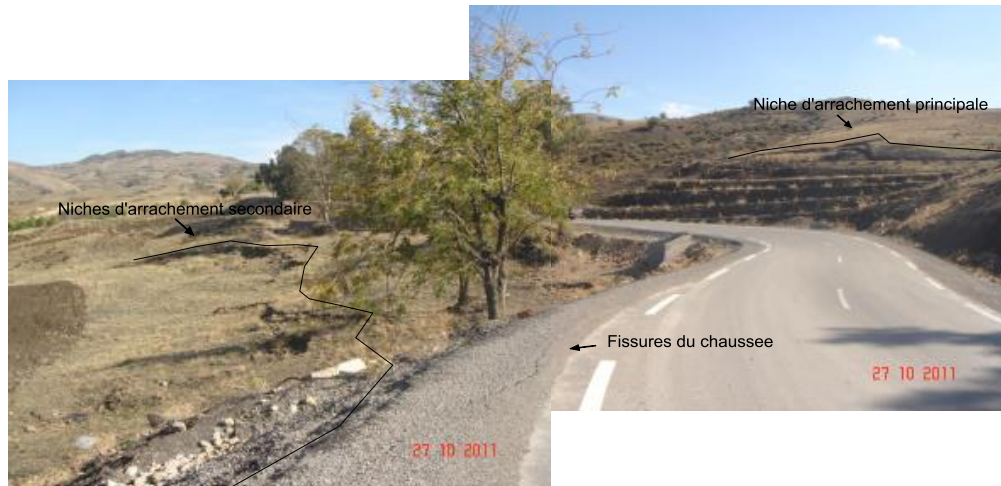
Photos VI.7 : Glissement touchant la nouvelle route
