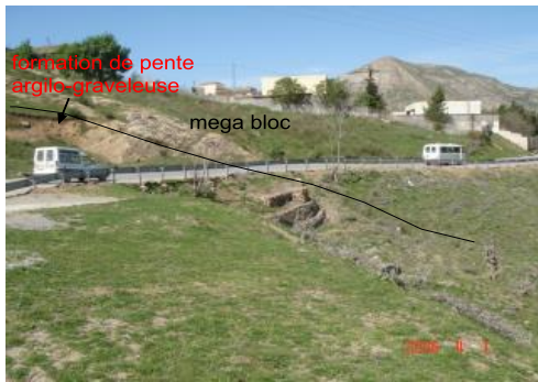
Glissement par ravinement
