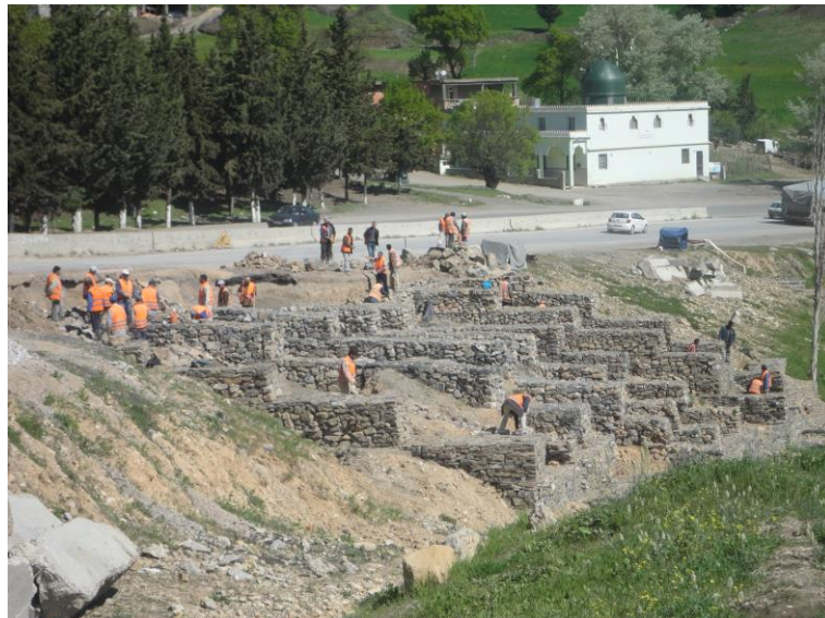
Photo VI.5 : déroulement des travaux de confortement
