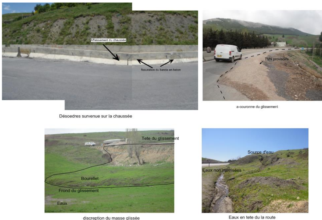
Photos VI.4 : description de glissement sur la RN09 de Dhiafet
