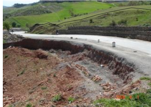
Travaux de confortement
