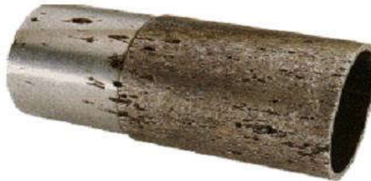
Figure. I.15 : Corrosion par piqûres d'un acier inoxydable [11].
