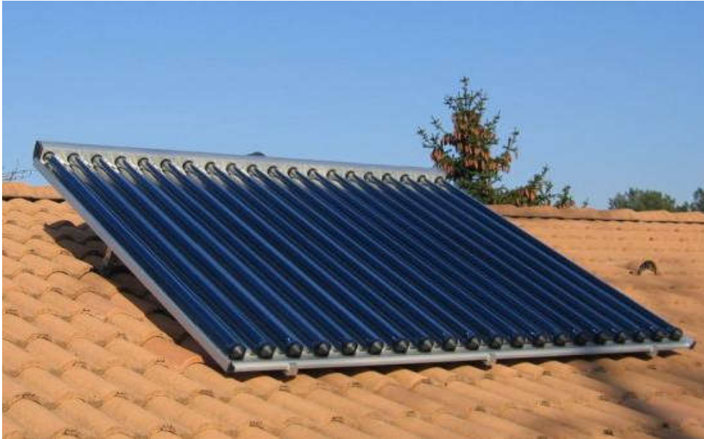
Fig. III.3. Capteur sous vide [15]
