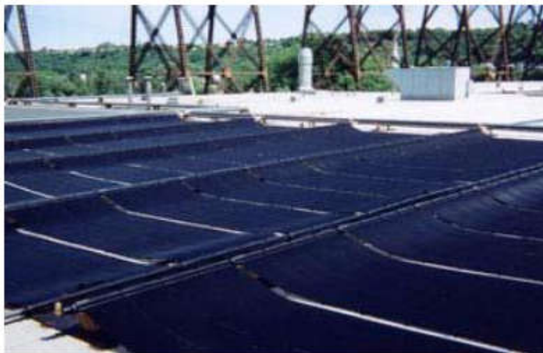
Fig. III.1. Capteurs plans sans vitrage [15]
