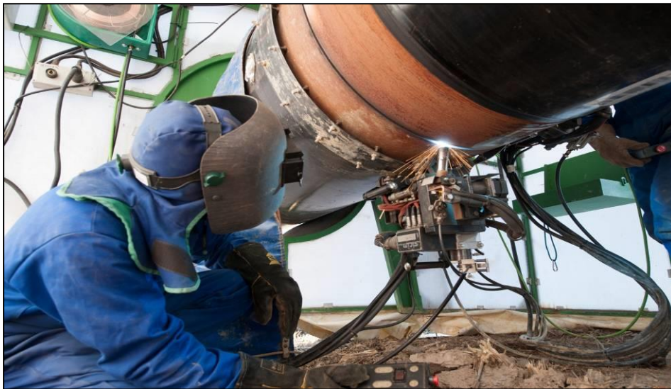
Figure 1-4 : principe de soudage automatique.[4]
