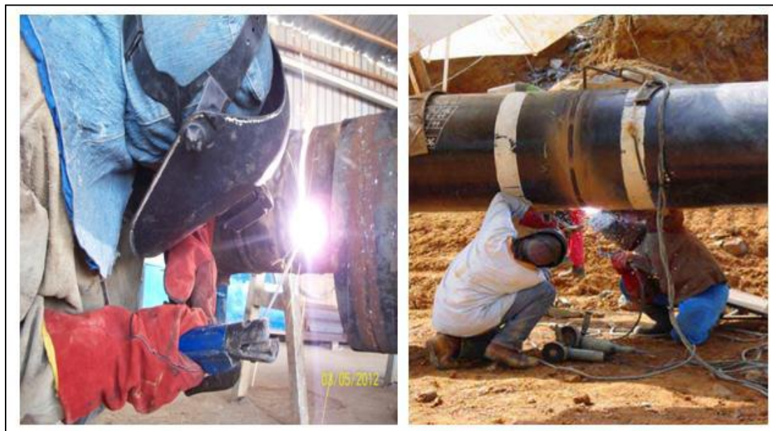
Figure 1-3 : Soudage des pipelines (type manuel). [4]
