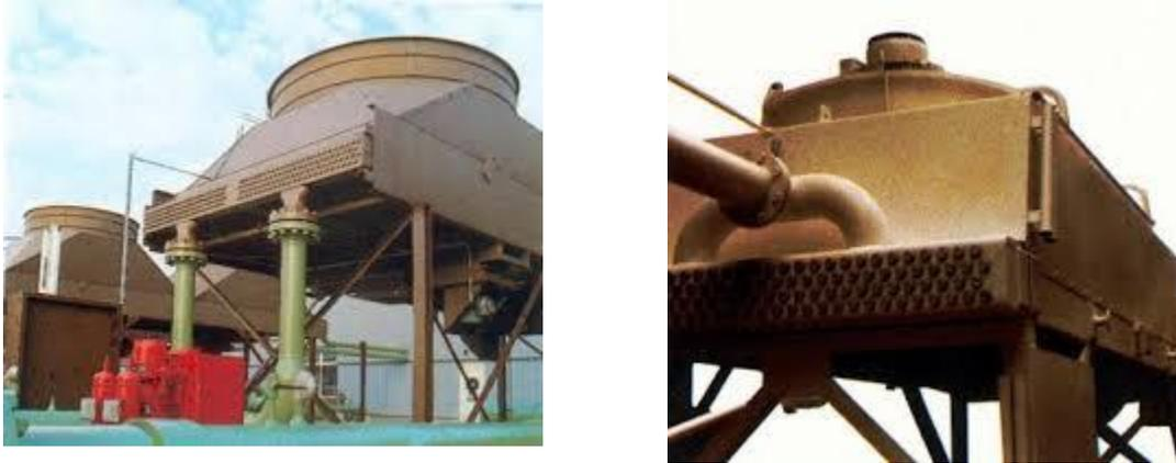
**Figure. II.8.** Aéro-réfrigérant avec vue sur la ligne d'alimentation et bouchons de tube. [6]
