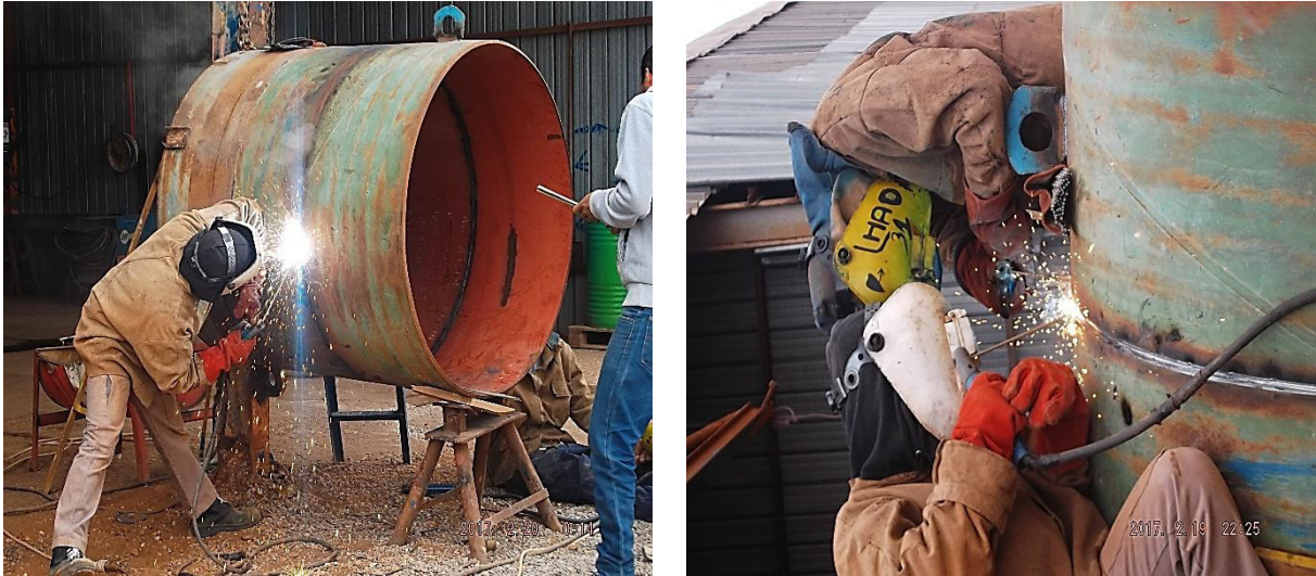
Figure III.3 : Soudage à l'arc électrique à COSIDER.
