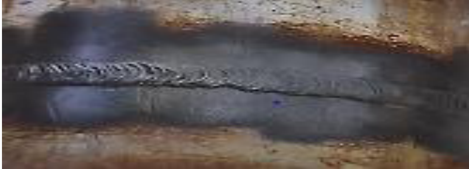
Figure III.11 : La finition du soudage après 4 passes de l'acier X60 soudé manuellement avec l'électrode enrobée.
