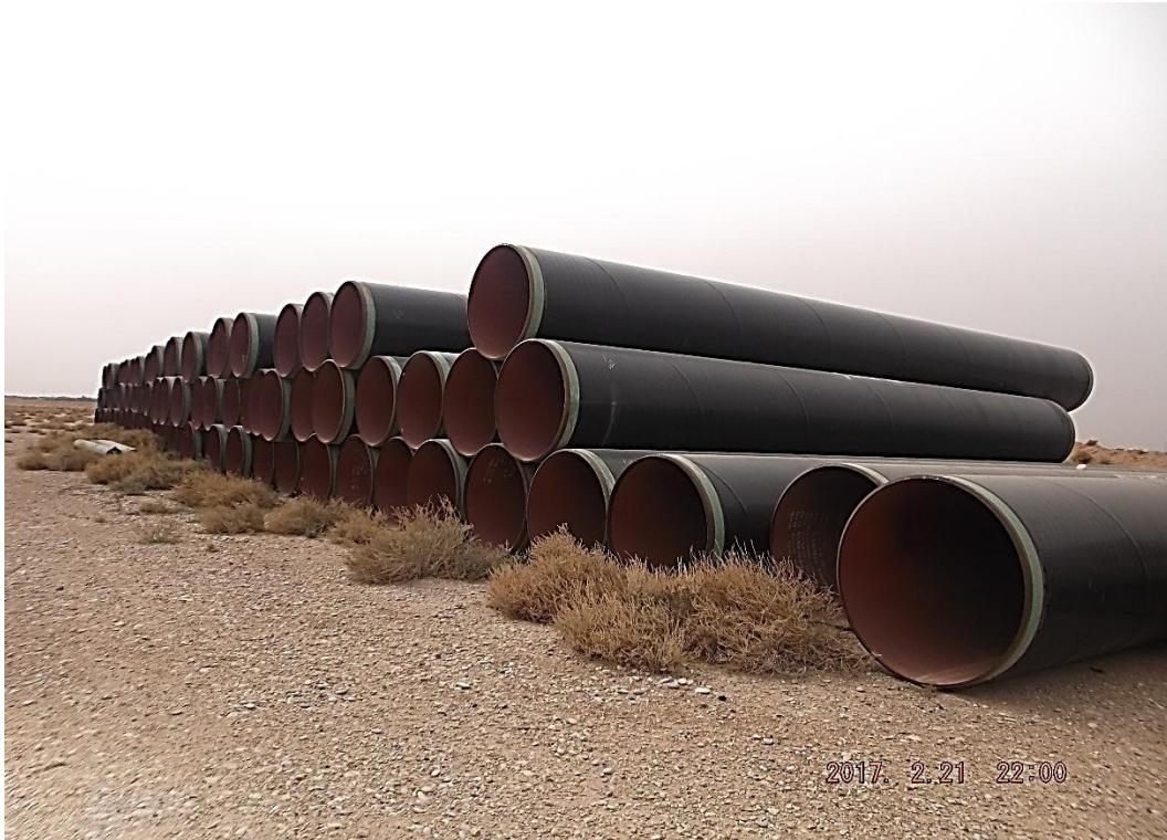
Figure III.1 : Pipe au niveau de COSIDER.
